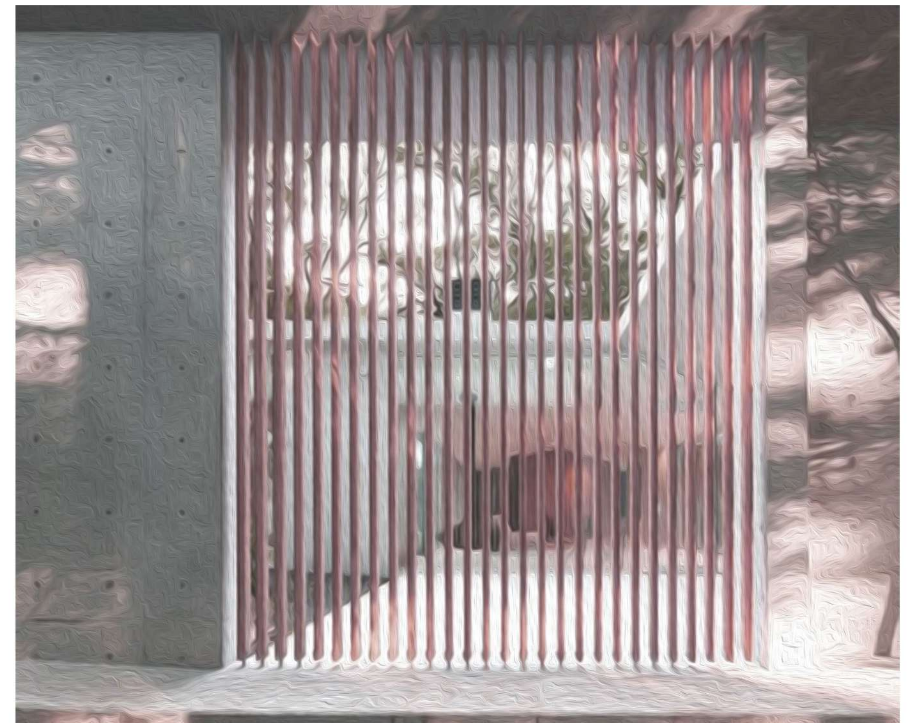
CELOSÍAS VERTICALES, PIEZAS PREFABRICADAS DE MADERA.
