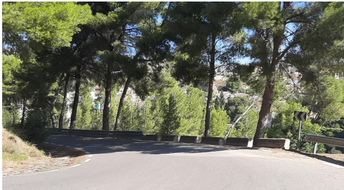
Figura 31: Bloques de hormigón situados en el PK 05+400. (Fuente: Elaboración propia)
