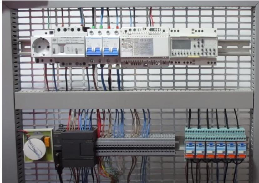
Ilustración 2 Automatismo Industrial implementado mediante lógica programada [4]
