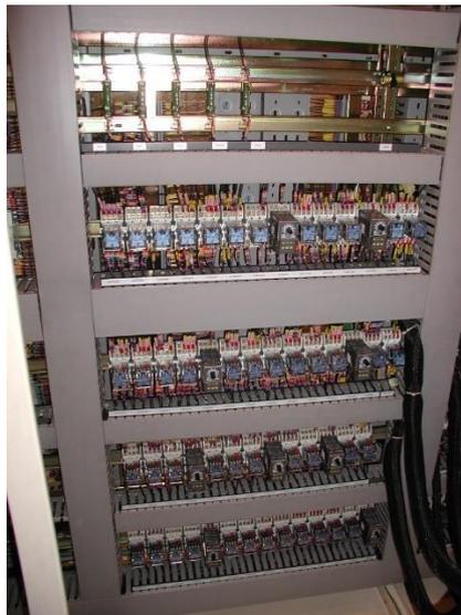
Ilustración 1 Automatismo industrial implementado mediante lógica cableada [3]
