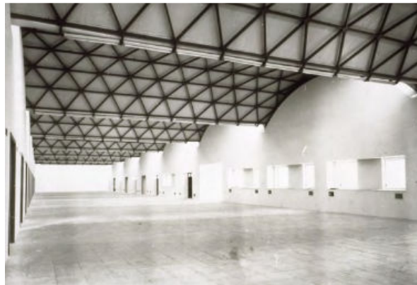
Figura 65. Cubierta de la nave de ensayos del Instituto Torroja. (5)
