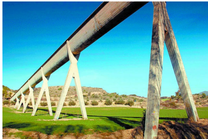
Figura 61. Aspecto actual del Acueducto de Alloz. (40)
