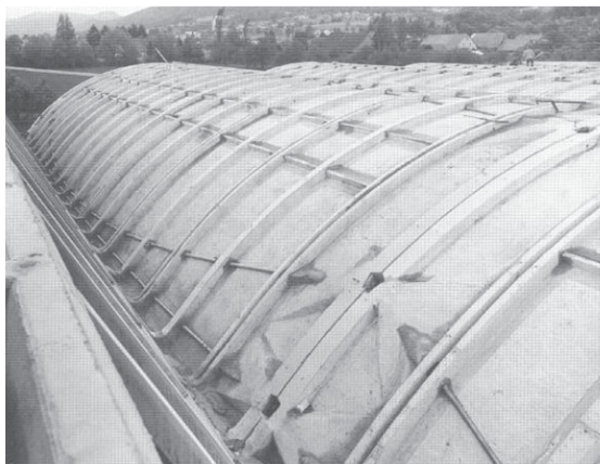
Figura 41. Almacén del Consorcio Wagen realizado por Hossdorf. (11)
