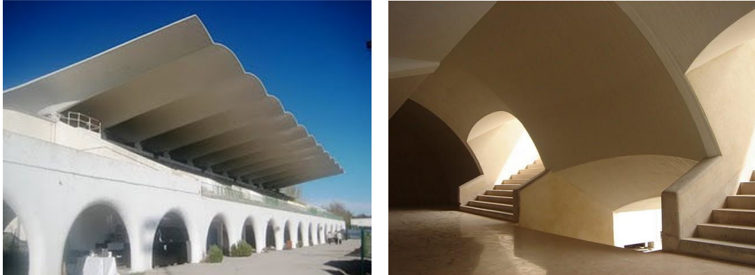
Figura 53. Vista actual del exterior y del interior. (52) y (53)
