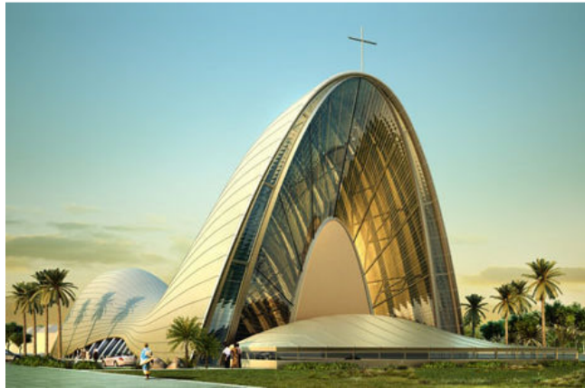
Figura 76. Imagen general de la Iglesia Católica de la Transfiguración de Lagos. (31)
