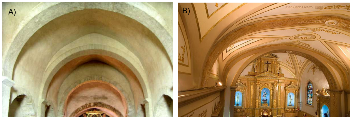
Figura 72. De izquierda a derecha: A) Imagen de la bóveda ojival de la Iglesia de Vinça. Languedoc-Roussillon; B) Imagen de la bóveda carpanel de la Iglesia de San Miguel Arcángel. (33) y (34)
