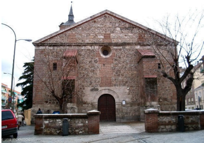
Figura 82. Aspecto actual del exterior de la iglesia. Todavía se puede observar en el muro exterior del ábside el perfil de apoyo elíptico de la antigua cubierta.
