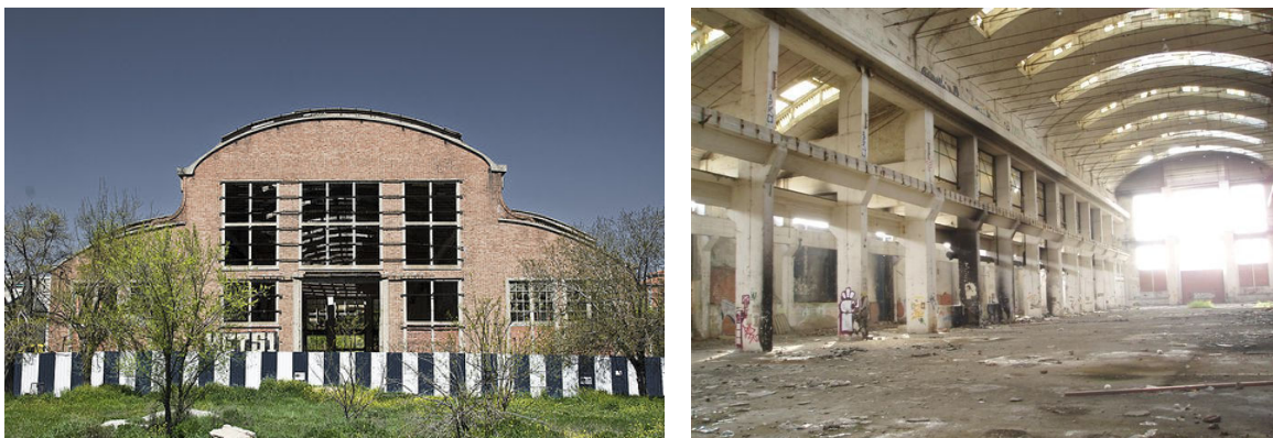
Figura 49. Vista frontal e interior de la nave Torroja en Villaverde . (37)
