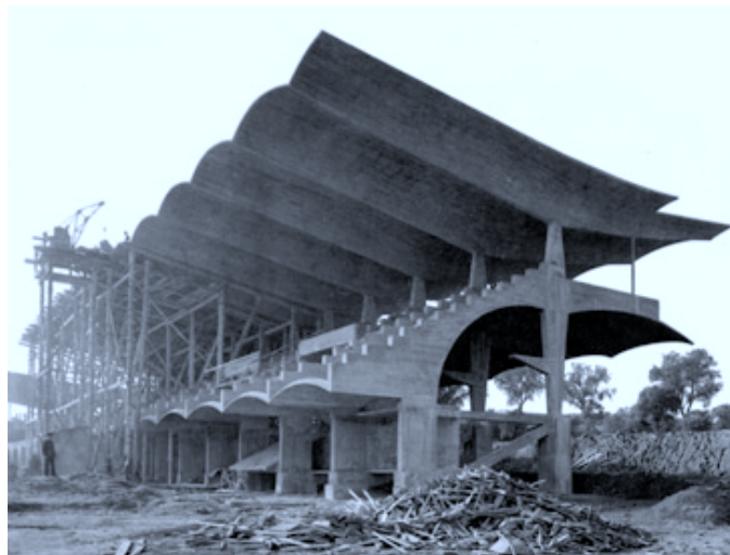
Figura 54. Imagen durante la construcción. (50)
