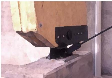
Figura 40. Imagen real fijación madera - hormigón. **Fabricante BCP uniones.**
