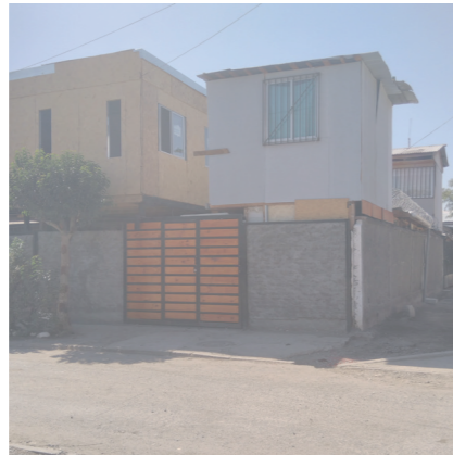
VIVIENDAS NUEVAS AMPLIACIONES EN ALTURA
