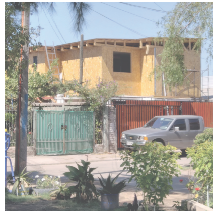
VIVIENDAS NUEVAS AMPLIACIONES EN ALTURA
