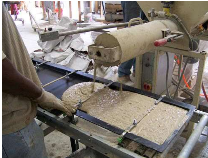
Figura 2.1.7. Colado y vibrado mortero preparado por el proceso de premezcla [ https://www.concretedecor.net/decorativeconcretearticles/cd-vol-10-num-6-august-september-20101/tools-concrete-mixers/05/03/2020 ].
