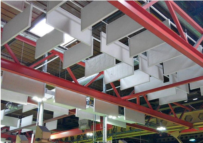
Ilustración 14. Baffles acústicos instalados en una empresa / Fuente: https://www.audiotec.es/productos/condicionamiento-acustico/baffles-acusticos/ (AUDIOTEC, Baffles acústicos: serie AATEC, 2020)
