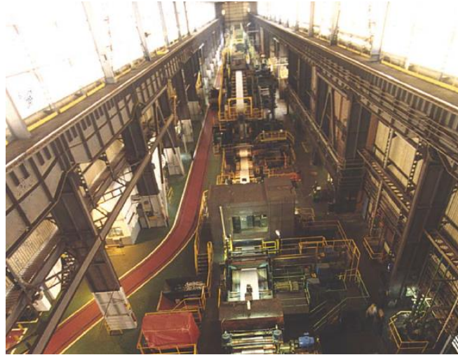
Ilustración 16. Ejemplo de la línea de Decapado donde la pared es de chapa / Fuente: (ArcelorMittal Sagunto, 2009)
