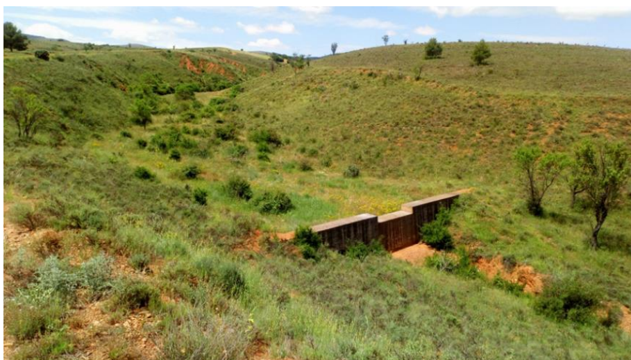
Figura 27. Dique de contención en el arroyo de Los Rebollares. Foto propia.
