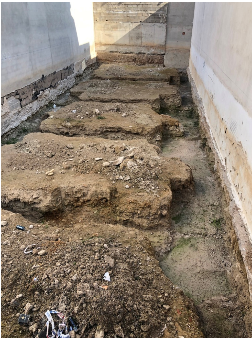
Imagen 3. Estado de la obra al inicio del TFG
