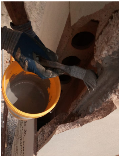
Figura 50. Aplicación de pasivante sobre las armaduras.
