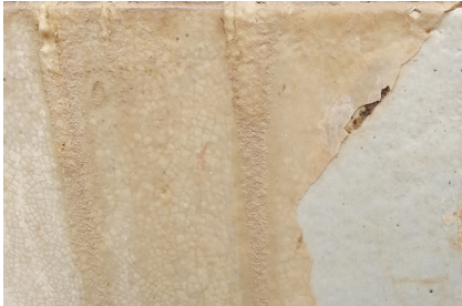
Figura 43. Detalle de sales en módulo A
