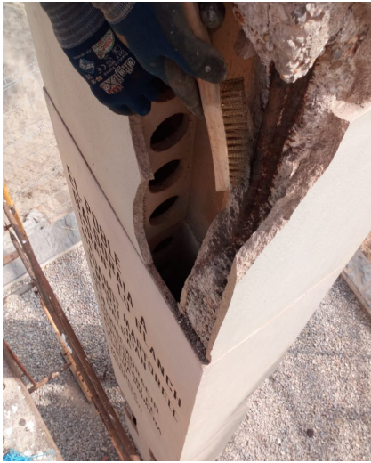
Figura 49. Cepillado de armaduras oxidadas.
