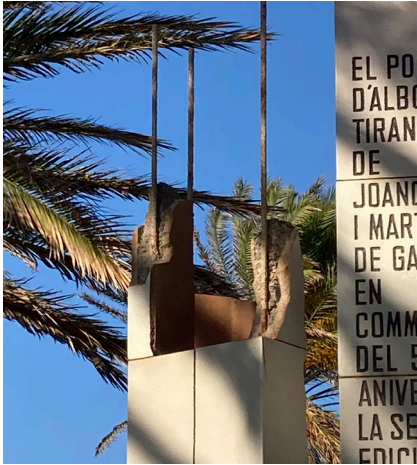
Figura 32. Detalle del estado de degradación del prisma C.
