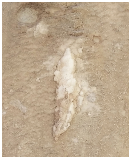
Figura 60. Detalle de volumen de la costra de las sales.
