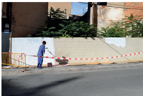
Fig. 65. Preparación del muro.
