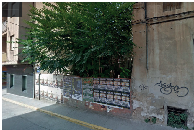
Fig. 62. Ubicación del muro.
