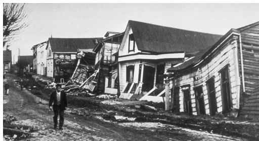
Vista de una calle en el centro de Valdivia tras el maremoto del 22 de mayo de 1960.
