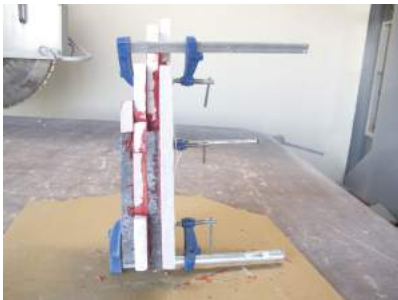
Figura 20: Aplicación de presión mediante gatos
