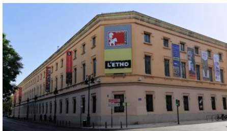
Fig. 2. Fachada del Centro Cultural la Beneficencia . Imagen realizada por la autora.
