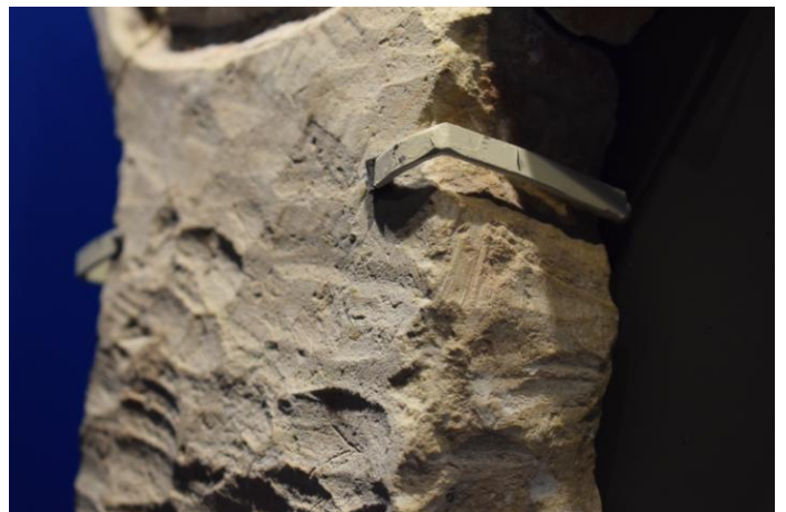
Fig. 16. Elementos de sujeción, con protección, de una pieza de piedra
