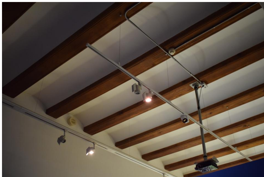
Fig. 26. Iluminación general de la sala por carril central. Imagen realizada por la autora.
