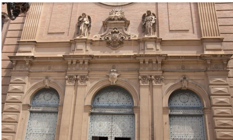
Fig. 4 Imagen de la actual fachada de la iglesia de la Compañía. Fotografía de la autora.
