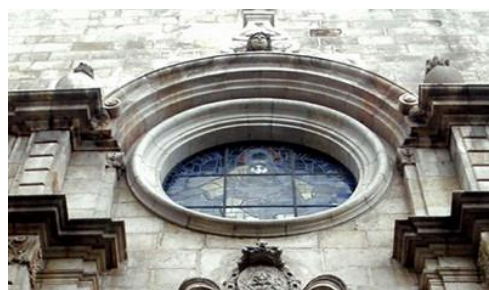
Fig. 49 Fachada de la Iglesia del Belén en Barcelona. Imagen del banco de imágenes Awegmann.
