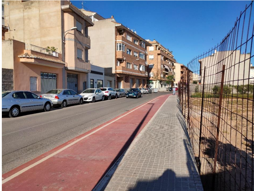
Foto 12.- Tramo del carril bici a su paso por el casco urbano. Fuente: Elaboración propia.
