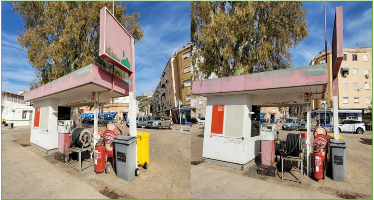
Figura 7. Estación de combustible (gasoil)
