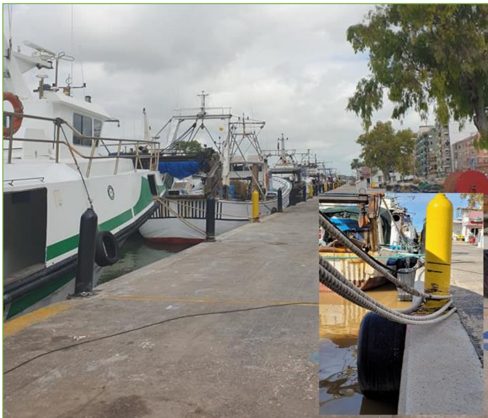
Figura 10. Muelle 1. Detalle del bolardo y defensa.
