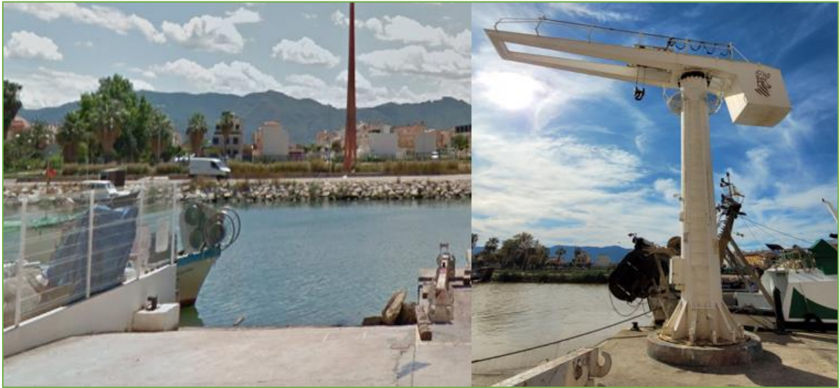
Figura 9. Rampa con grúa de 12 t.
