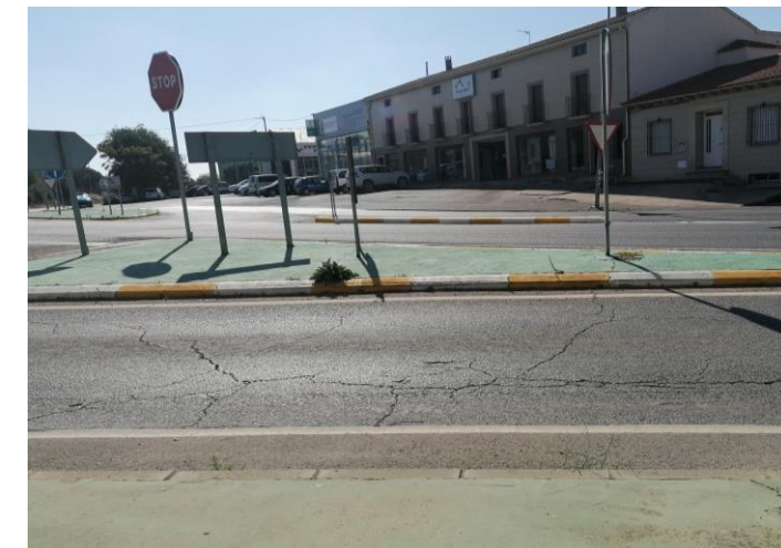
Figura 75: Marca continua de borde de calzada en el acceso 4
