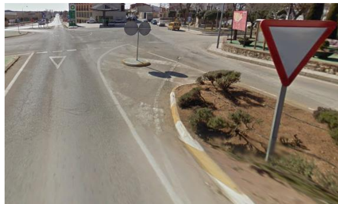
Figura 14: Señal vertical respecto a su línea de detención situada a más de 15m
