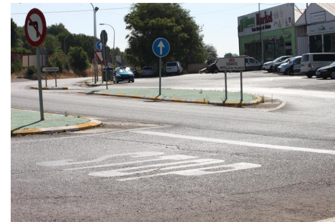
Figura 85: Línea de detención en glorieta
