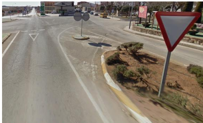
Figura 57: Inscripción de señal horizontal Ceda el Paso en acceso 1 a la glorieta
