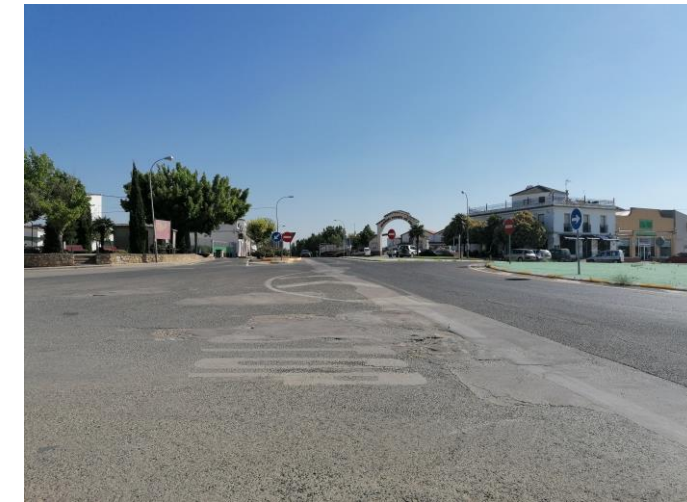
Figura 84: Línea de detención en acceso 5
