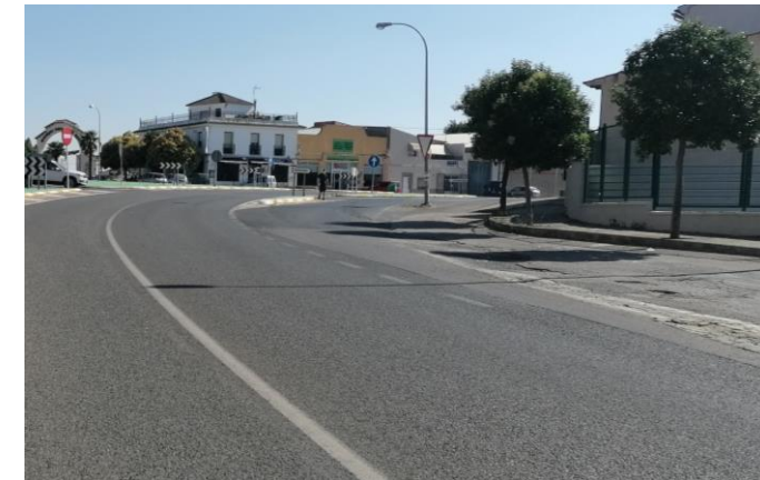
Figura 63: Separación de carriles en la salida al acceso 3 de la vía N-310
