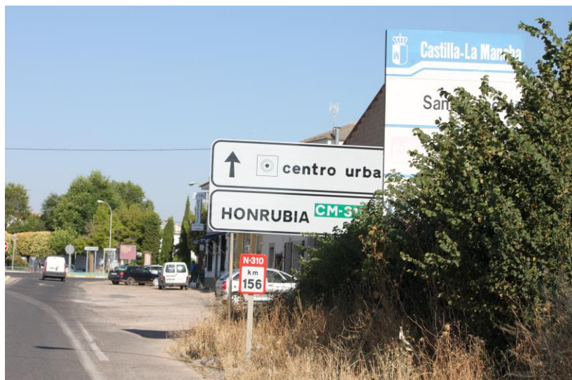
Figura 5: Mala visibilidad de señal informativa y de orientación por la vegetación
