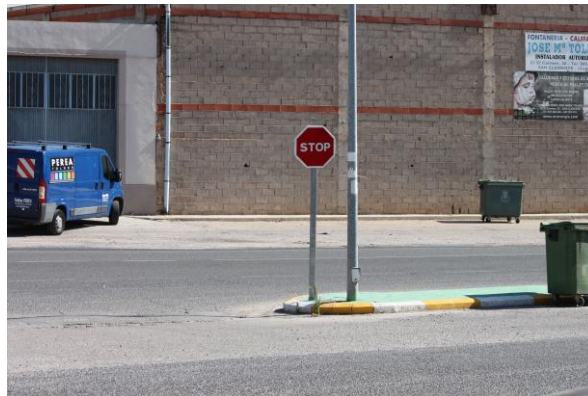
Figura 17: Señal vertical sin sus marcas viales correspondientes
