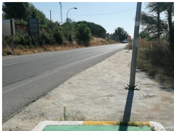
Figura 73: Marca continua de borde de calzada en el acceso 2
