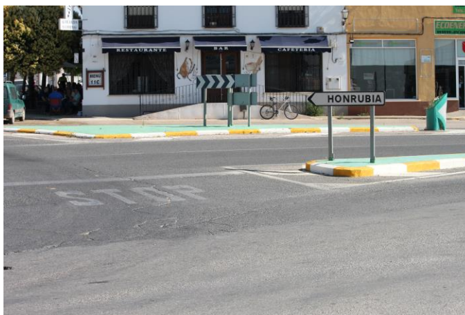
Figura 83: Línea de detención en acceso 3
