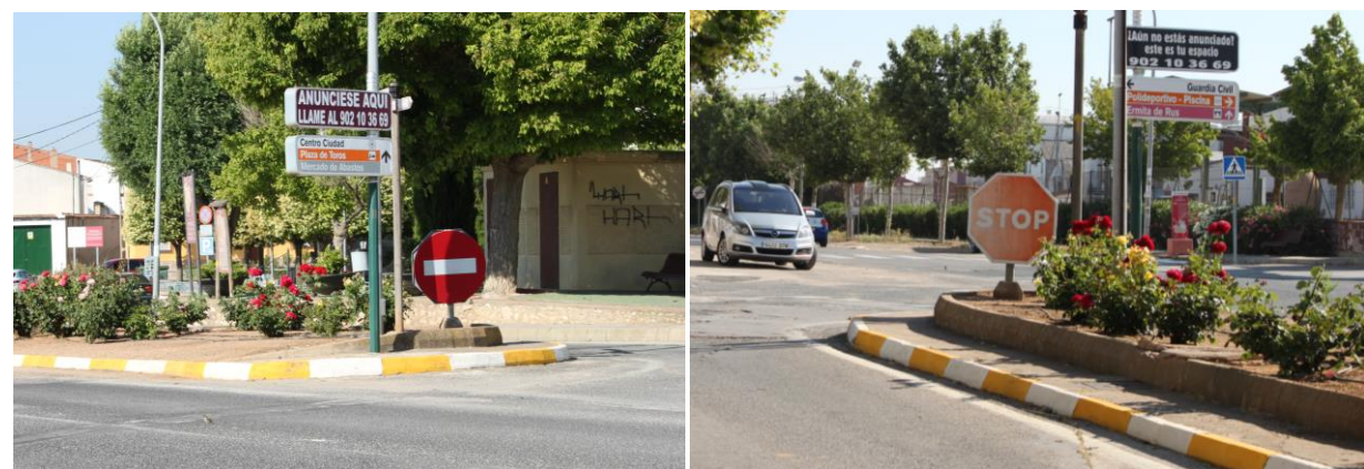
Figura 4: Señal de Prohibición de Entrada (izq) y señal Detención Obligatoria (dcha) sin altura mínima
