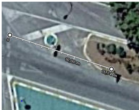
Figura 77: Marca transversal de ceda el paso en el acceso 1
