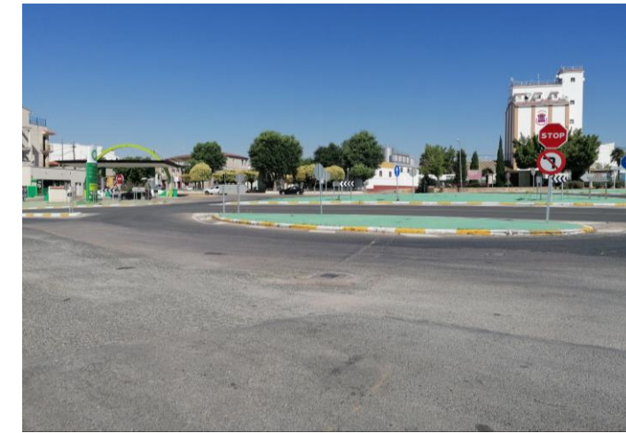
Figura 74: Marca continua de borde de calzada en el acceso 3
