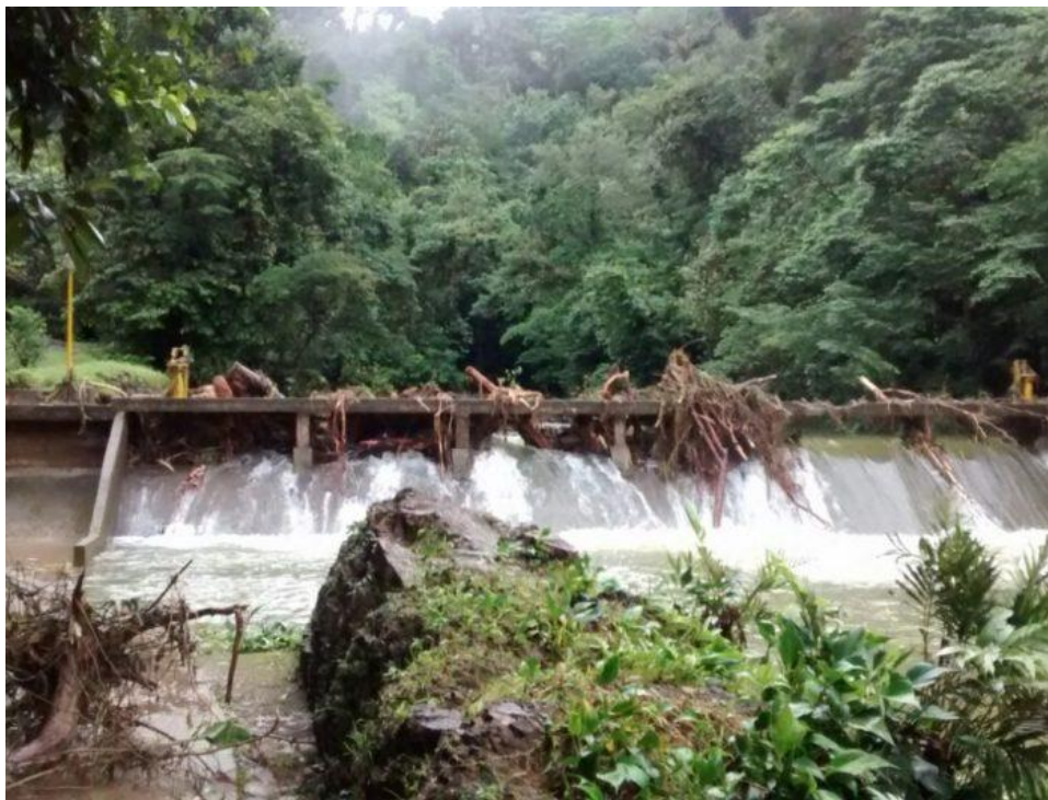
Figura 57. Planta de tratamiento de agua en Buenaventura.
