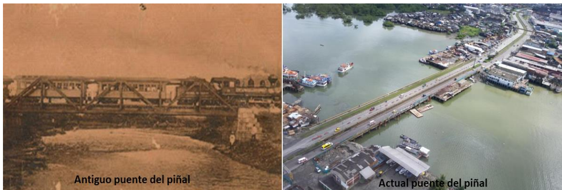
Figura 23. Puente del piñal y vía férrea de Buenaventura.
