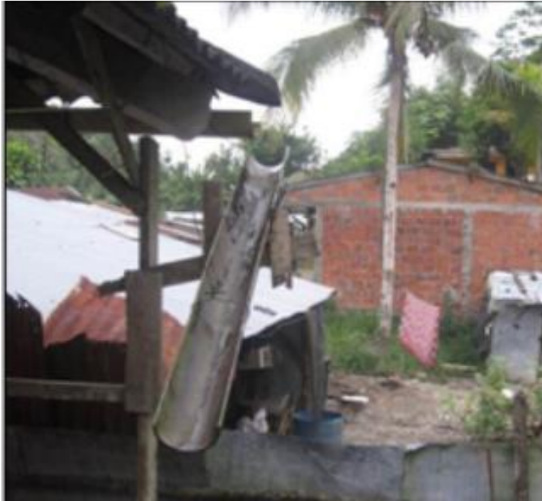
Figura 60. Sistema de recolección de agua lluvia.
