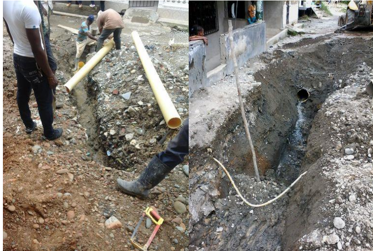
Figura 59. Mantenimiento e instalación de red sanitaria barrio Alfonso López Michelsen.
