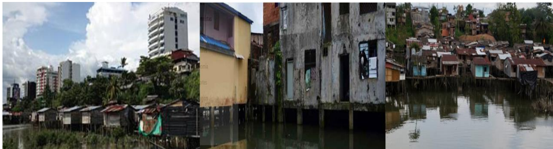
Figura 55. Viviendas afectadas por inundación.
