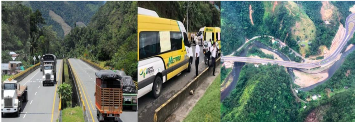
Figura 43. Vía nueva doble calzada, Cali-Buenaventura.
