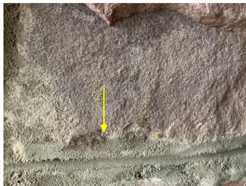
**Figura 8.** Toma de muestras de mortero procedentes del muro de cerramiento izquierdo. Fuente: SERRANO, 2020.
