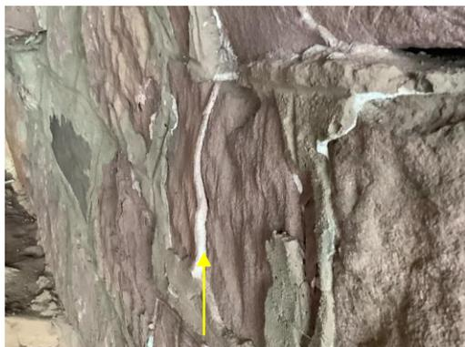
**Figura 7.** Toma de muestras de eflorescencias salinas procedentes de ascensión capilar del muro de cerramiento derecho. Fuente: SERRANO, 2020.
