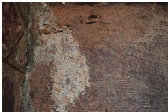
**Figura 37.** Detalle de mortero de cemento que oculta parte del *Motivo I* procedente del cerramiento. Fuente: SERRANO, 2020.
