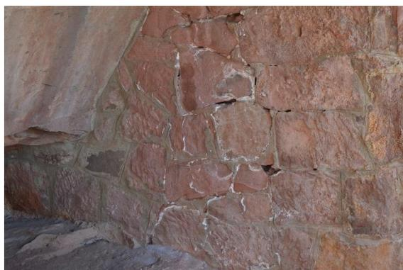
**Figura 24.** Eflorescencias salinas en los sillares del muro de cerramiento derecho (desde el punto de vista del espectador). Fuente: SERRANO, 2020.
