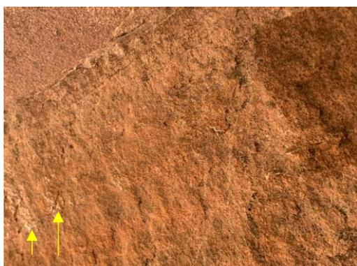
**Figura 9.** Superficie pétreo tras la aplicación de productos consolidantes *in situ*. Señalado: brillo generado por la precipitación de *Nano Estel®*. Fuente: SERRANO, 2020.
