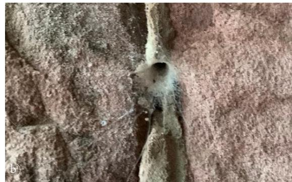
Figura 30. (a) Telarañas y (b) nidificación de arácnido en la junta entre sillares. Fuente: SERRANO, 2020.
