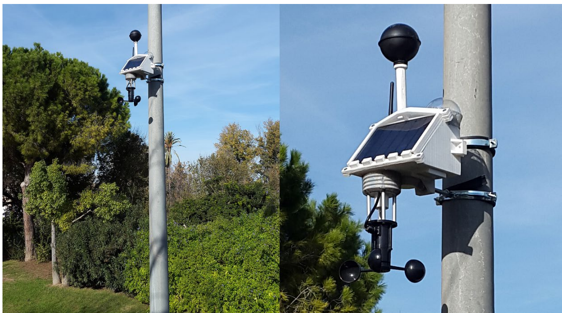
Figura 51. Transmisor HSM5 instalado.
