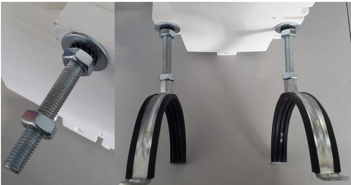
Figura 8. Instalación de las abrazaderas.
