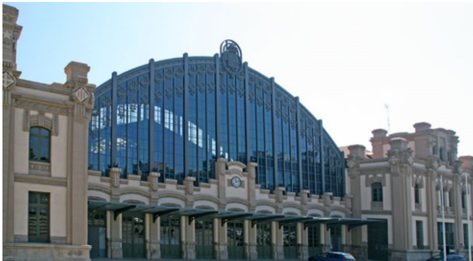
Figura 15. Fotografía de fachada principal estación Barcelona Nord. Fuente: fotografía de los autores.
