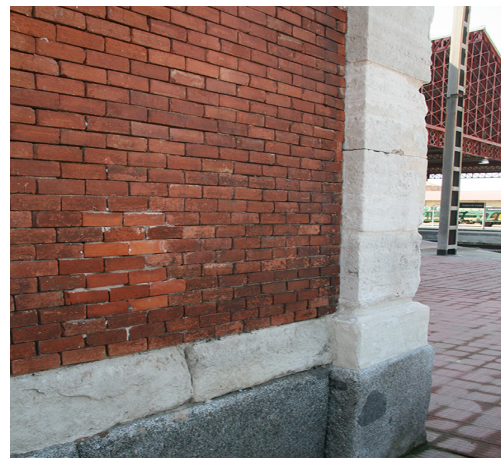
Figura 5. Paramento estación de Medina del Campo. Fuente: fotografía de los autores.
