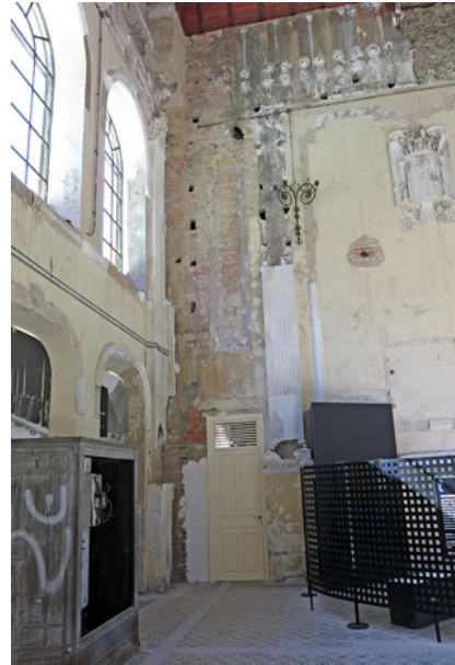
Figura 12. Detalle construcción en la estación de Canfranc. Fuente: fotografía de los autores.
