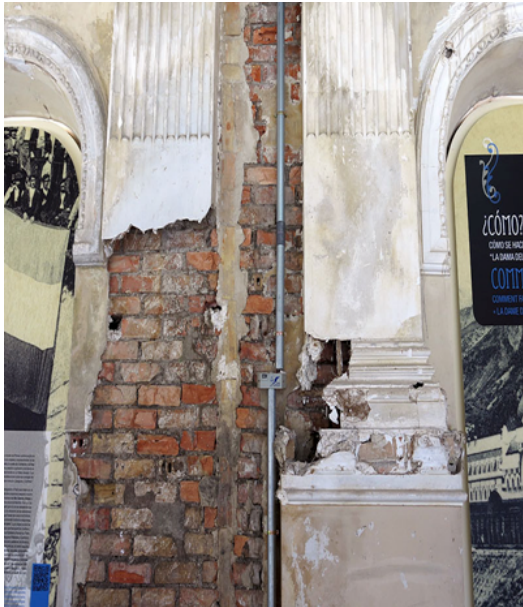
Figura 11. Detalle de fábrica en la estación de Canfranc. Fuente: fotografía de los autores.
