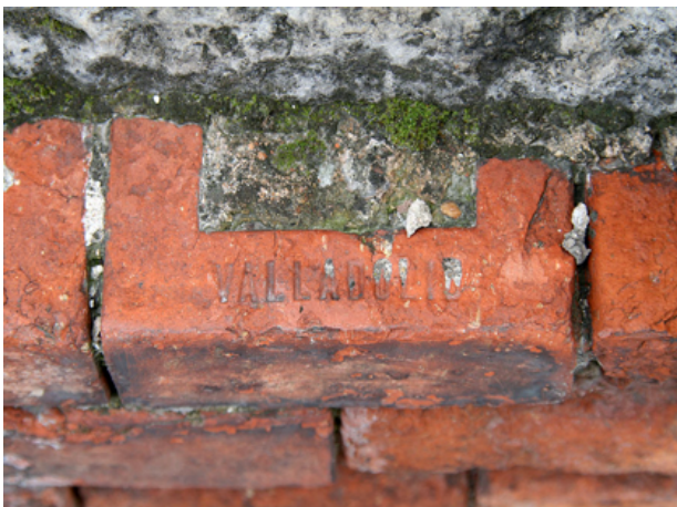
Figura 4. Paramento estación de Medina del Campo. Fuente: fotografía de los autores.
