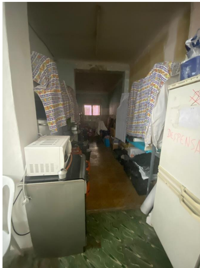
Ilustración 20. Zona derecha planta baja. Actual uso: almacén.
