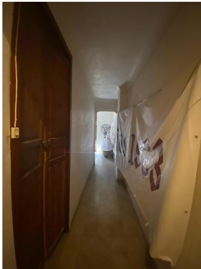
Ilustración 26. Pasillo principal planta primera hacia zona Oeste.
