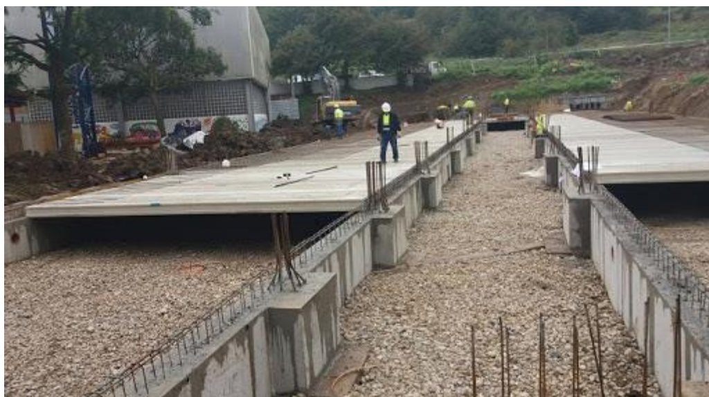
Ilustración 9. Forjado sanitario con placa alveolar.
