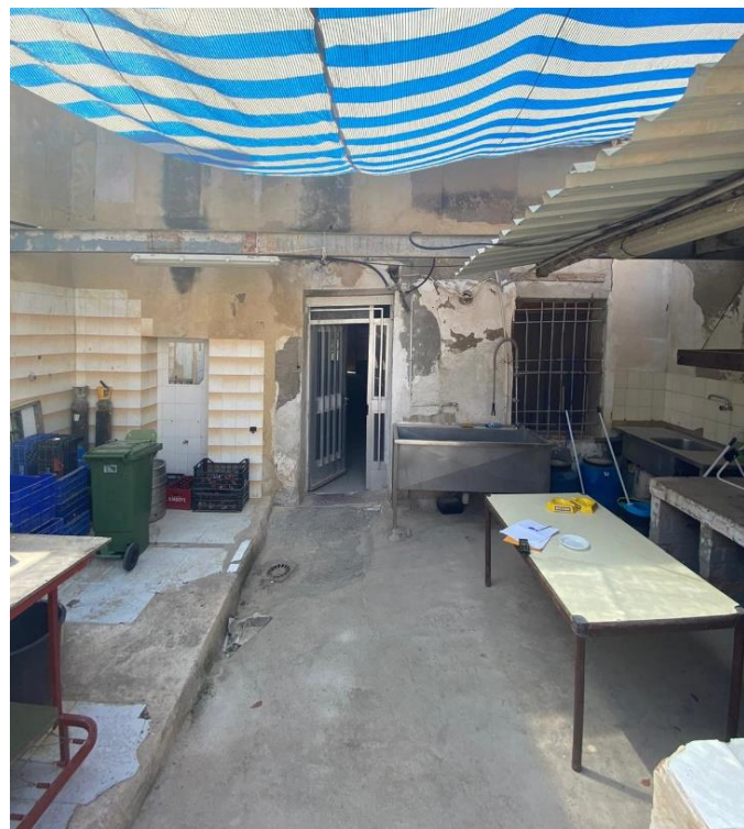
Ilustración 12. Parte inferior fachada trasera en C/ José Luis Jiménez Vargas.
