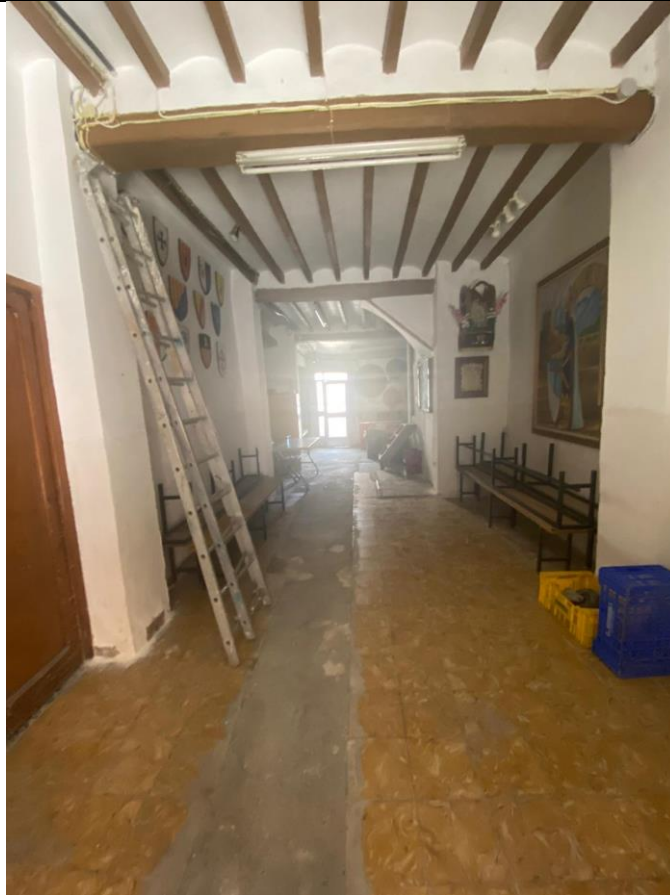
Ilustración 19. Planta baja desde entrada principal. Desde Oeste hacia Este.
