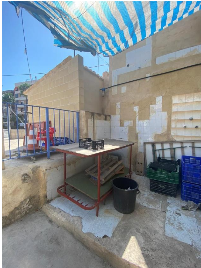
Ilustración 16. Parte derecha salida a patio exterior desde planta baja.
