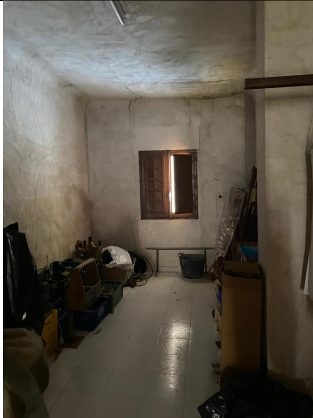
Ilustración 31. Ventana fachada secundaria planta primera.
