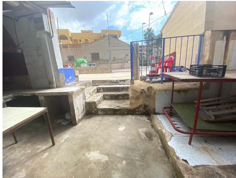
Ilustración 15. Salida a patio exterior desde planta baja.
