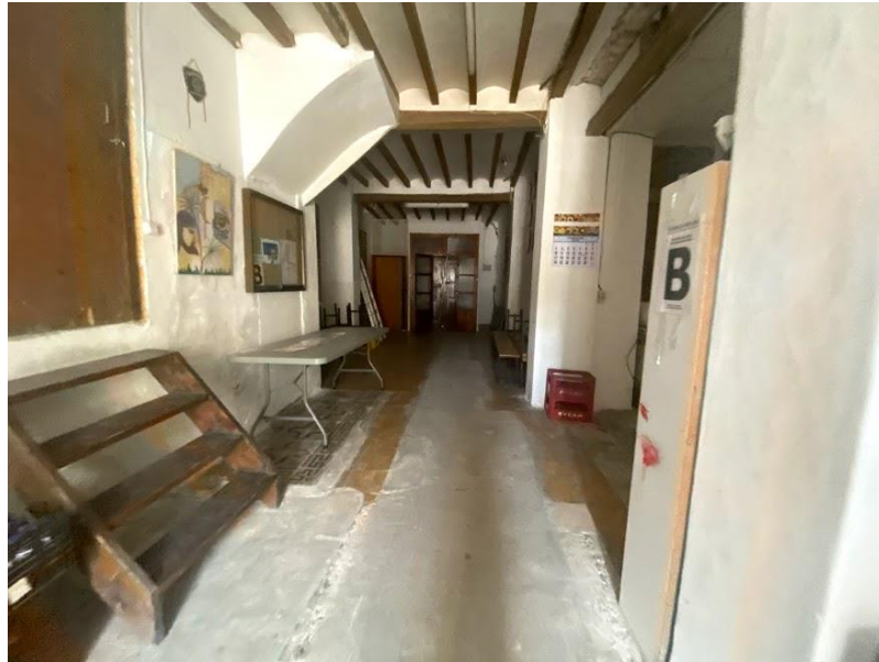
Ilustración 17. Planta baja desde entrada secundaria. Desde zona Este hacia Oeste.
