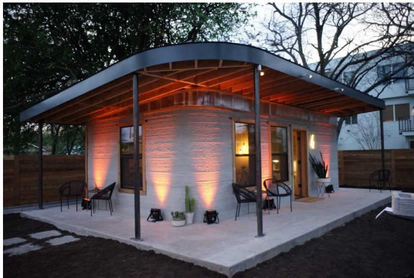
Figura I.15 Casa construida mediante impresión 3D.
