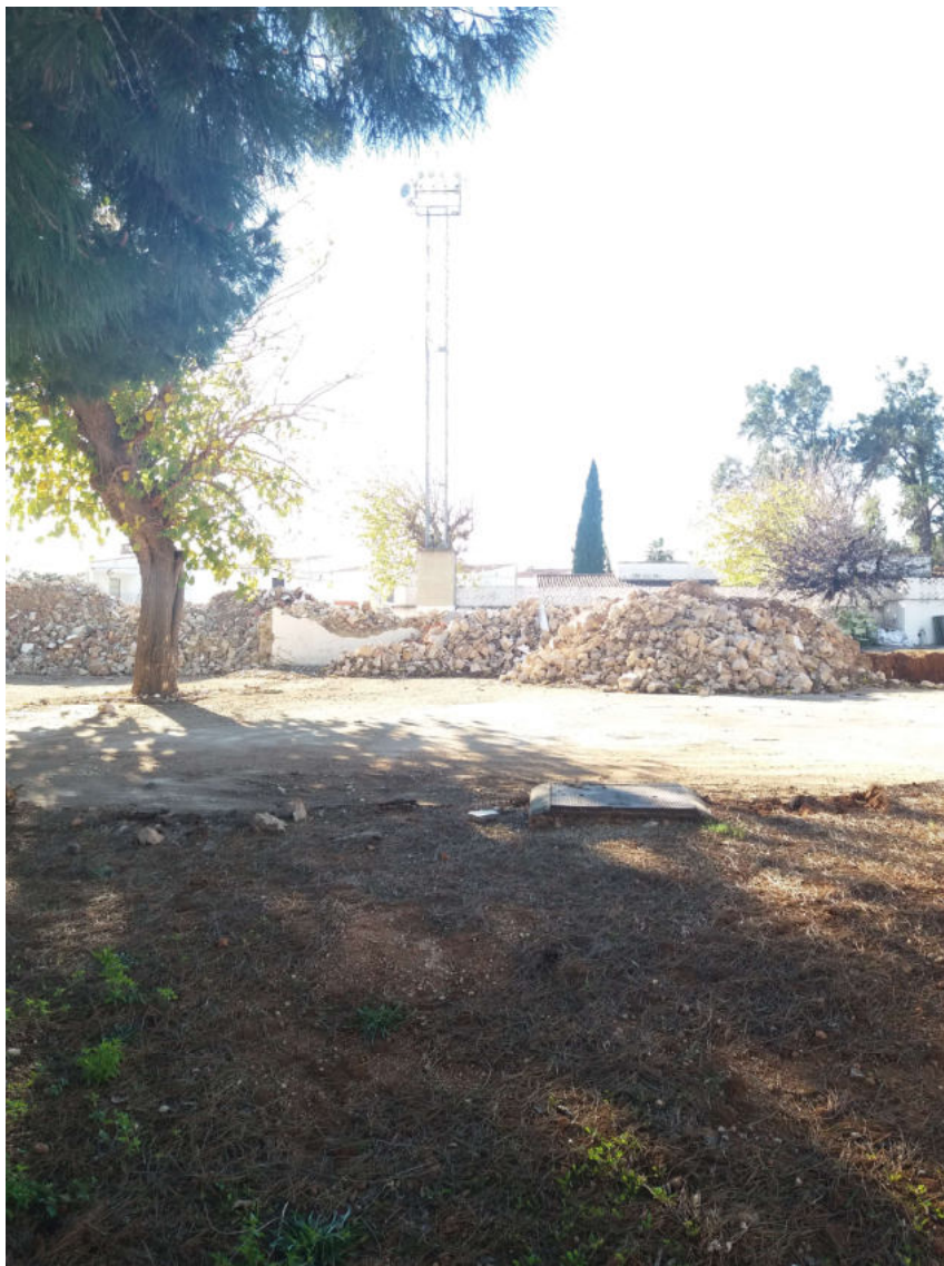
DEMOLICIÓN EDIFICIO EXISTENTE
