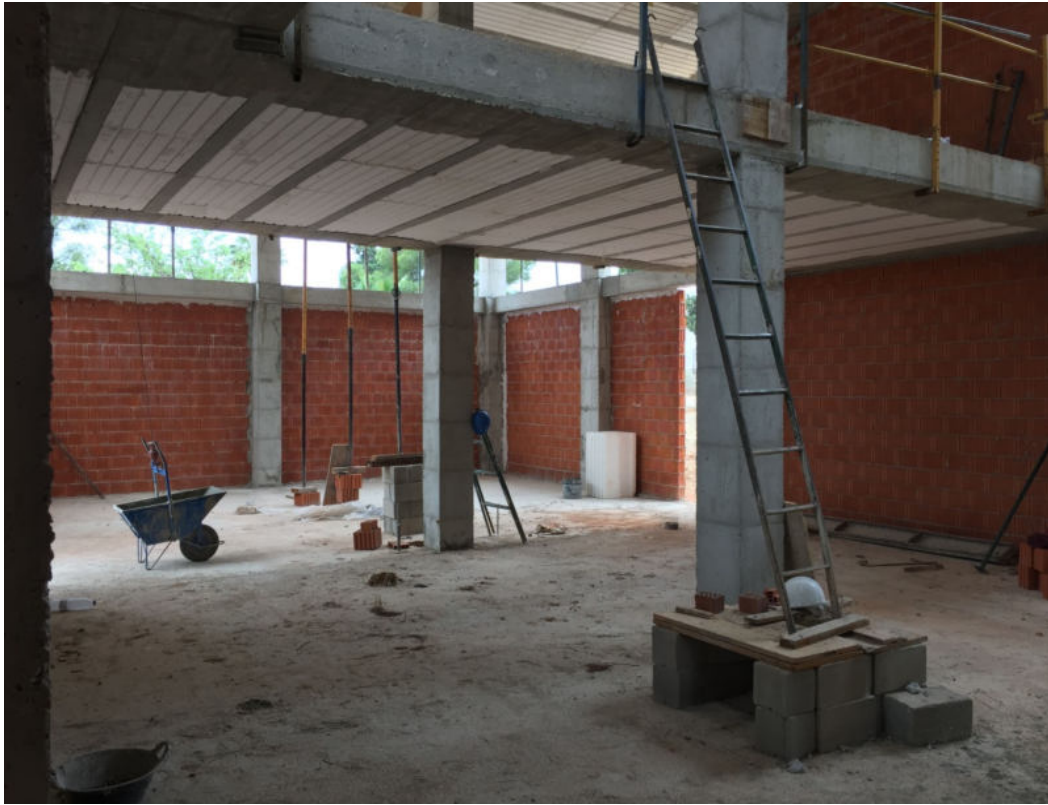
CONSTRUCCION DE PARAMENTO VERTICAL
