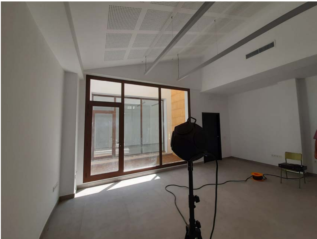
Figura 41_ Comprobación de TR En Aulas
