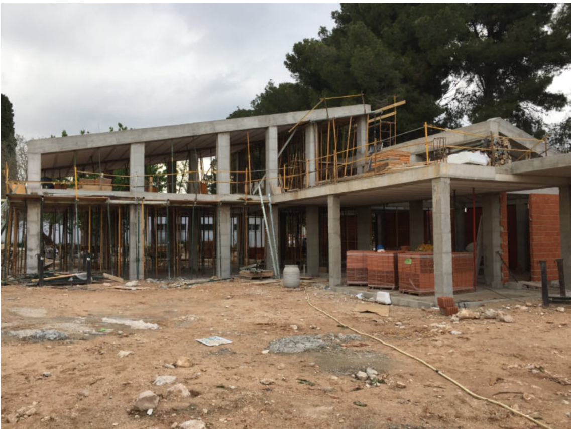
CONSTRUCCION DE FORJADO 2
