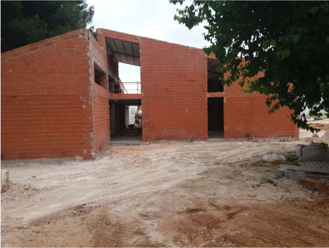
CONSTRUCCION DE PARAMENTO VERTICAL
