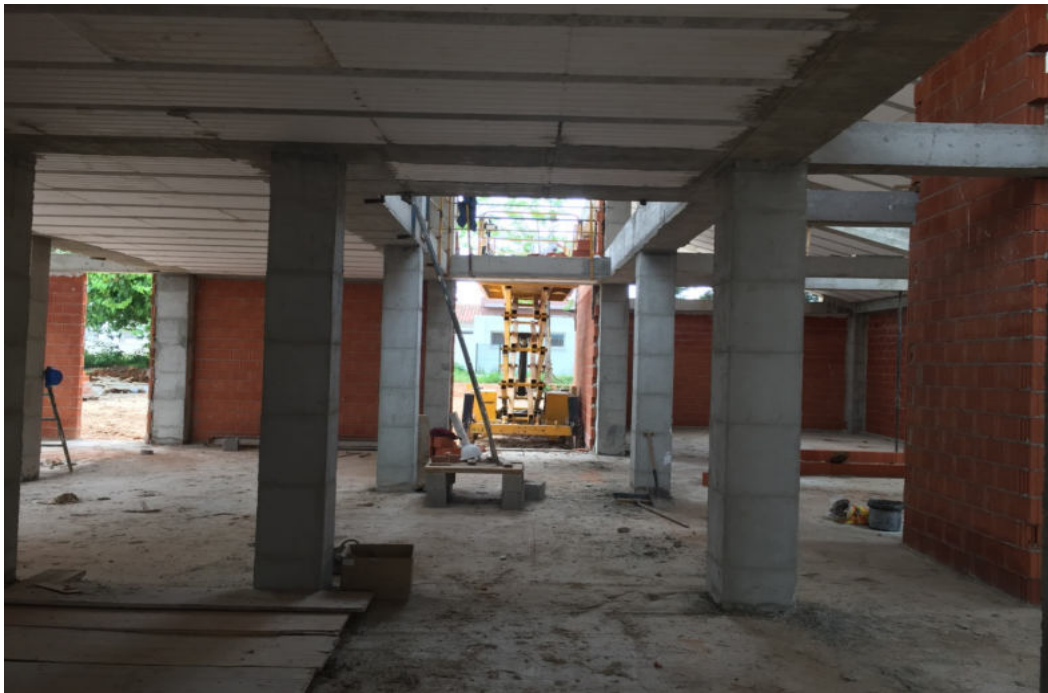
CONSTRUCCION DE PARAMENTO VERTICAL
