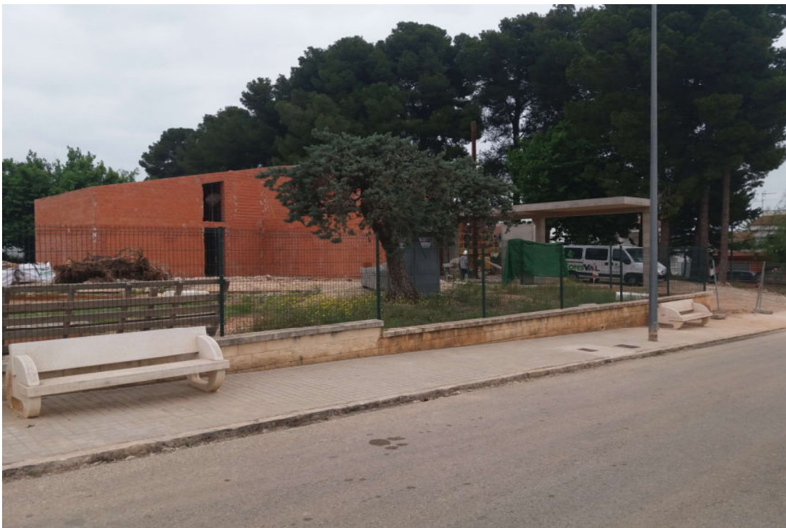
CONSTRUCCION DE PARAMENTO VERTICAL
