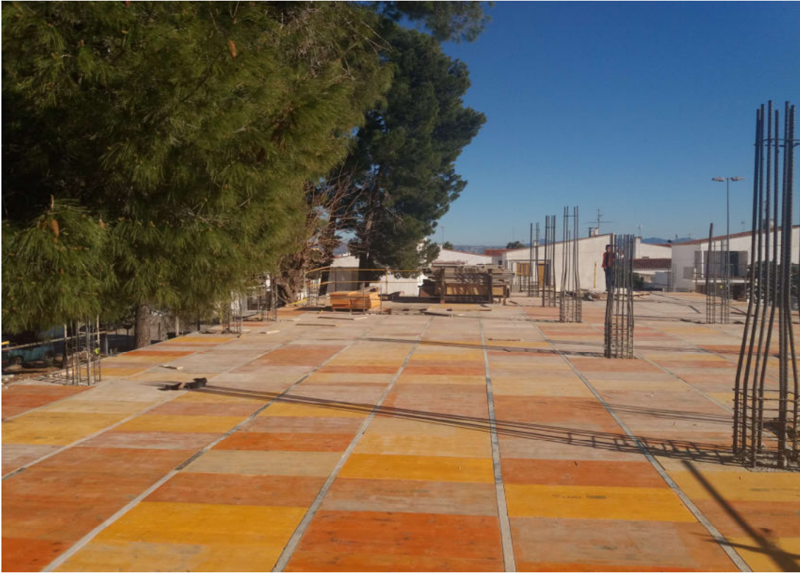
CONSTRUCCION DE FORJADO 1
