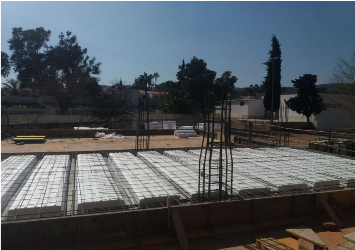
CONSTRUCCION DE FORJADO 1
