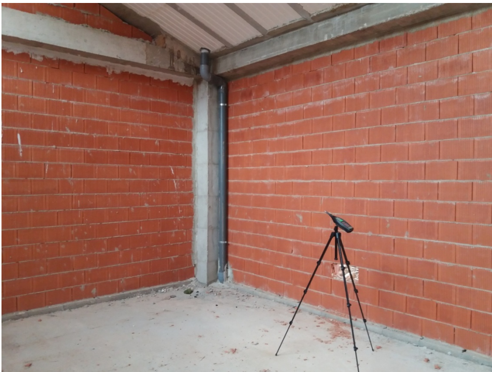
Figura 35_ Medición acústica en fase de ejecución
