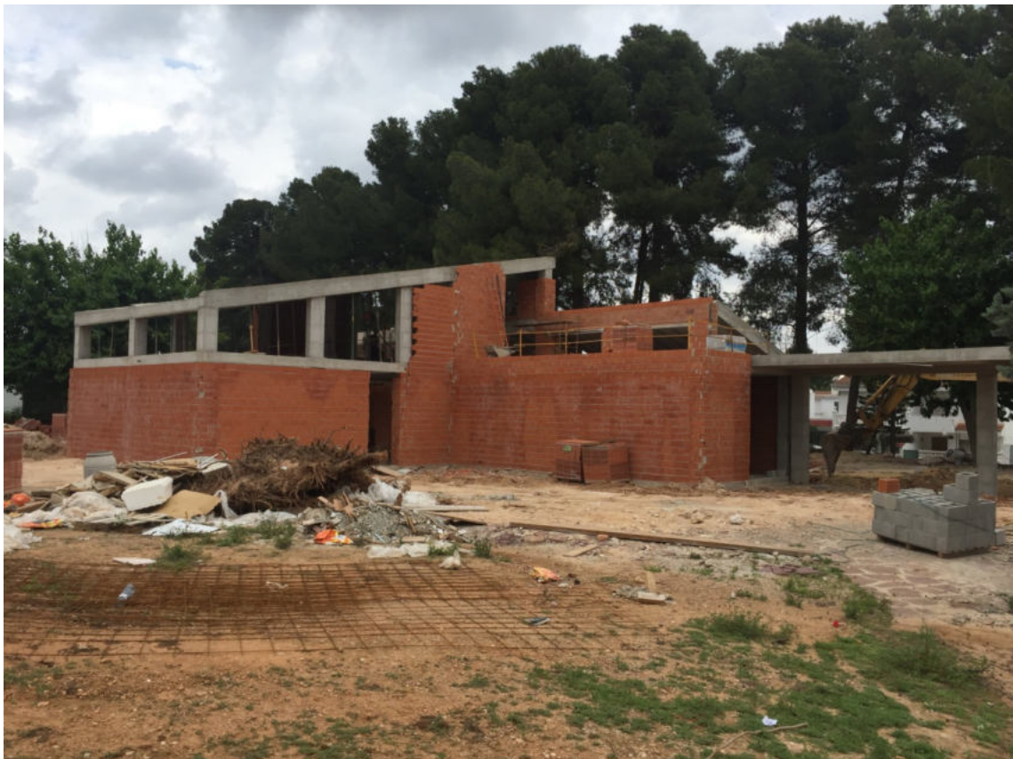
CONSTRUCCION DE PARAMENTO VERTICAL
