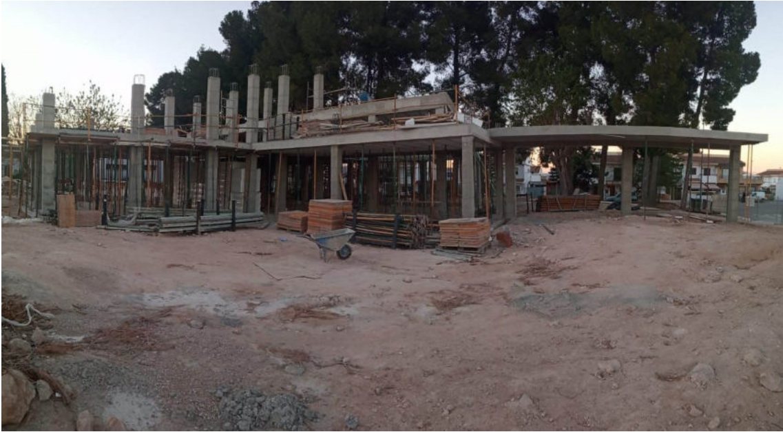
CONSTRUCCION DE FORJADO 1
