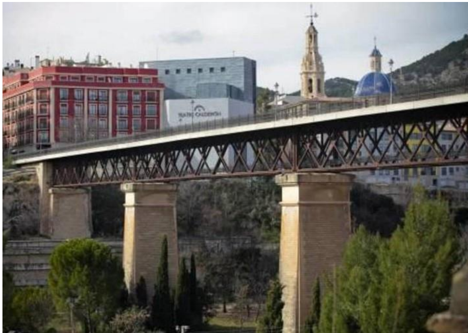
Ilustración 2 Viaducto de Canalejas
