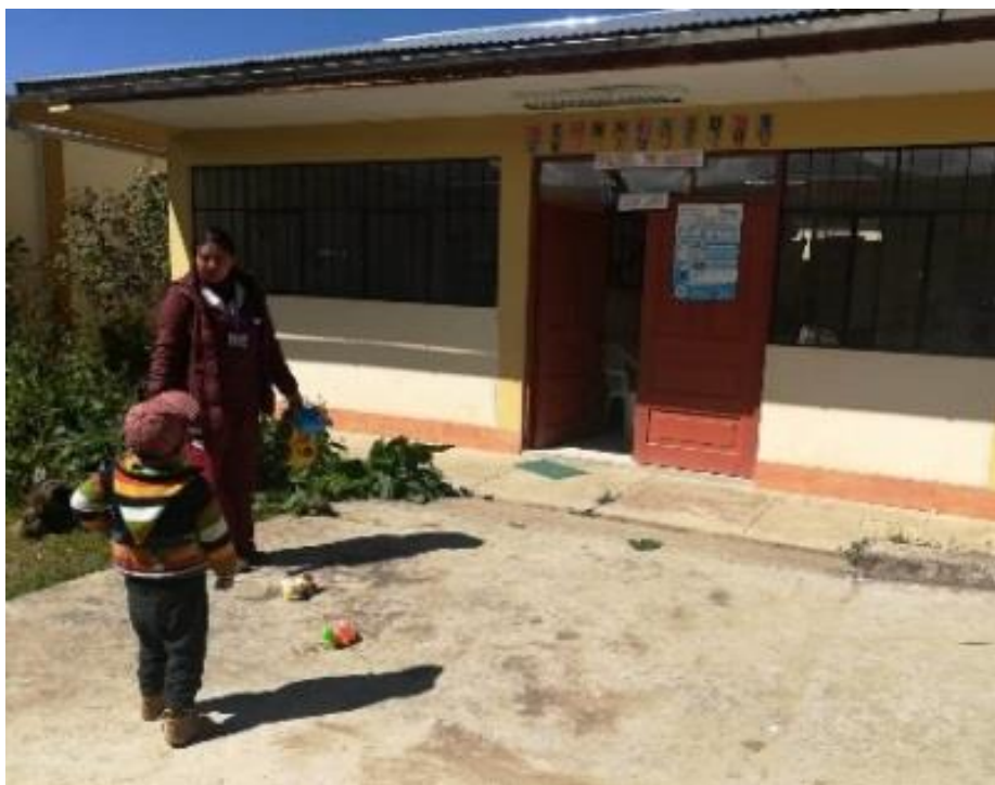
Figura 49: El acceso al Puesto de Salud de Huacuas
