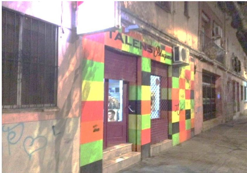
Figura 33. Foto de fachada. Fuente: Propia.
