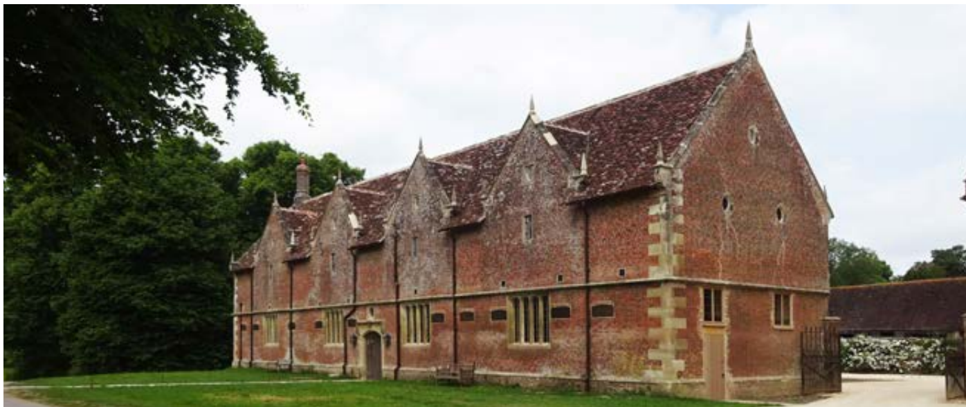
1. Fachadas sur y este después de las obras / The south and east elevations after the works
