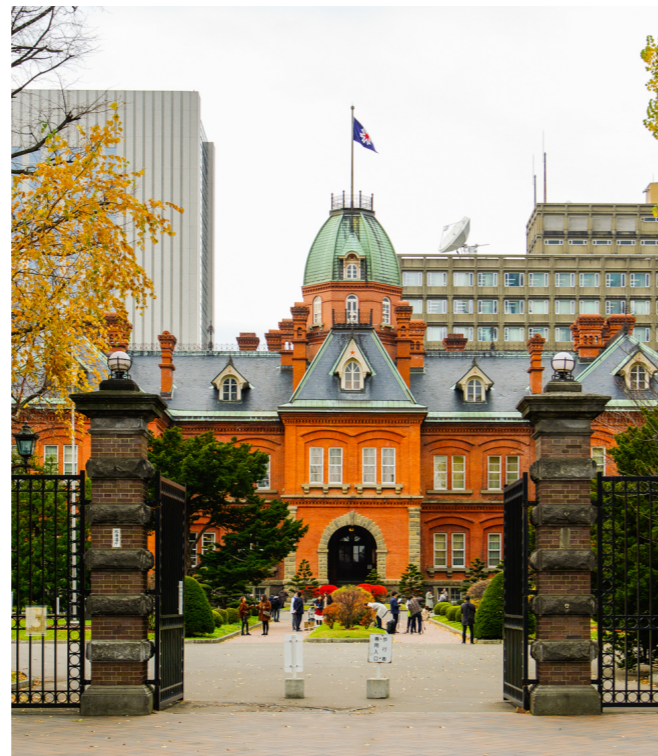
06. Antiguo Edificio del Gobierno
