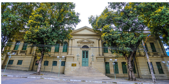
Figura 70 Imagen actual del edificio sede del ayuntamiento. Aunque presente algunos problemas de mantenimiento en fachada, guarda la concepción neoclásica original. Fuente: Dias (2020).
