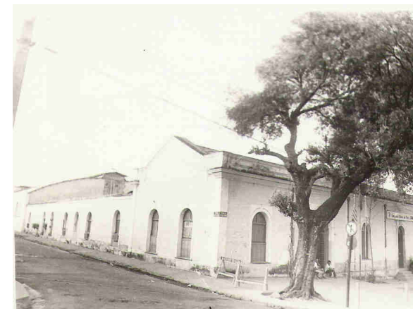
Figura 54 Una de las raras fotografías históricas del edificio que abrigaba la maquinaria de embarcaciones de la antigua Compañía de Navegación del río Parnaíba. Fuente: Acervo FUNDAC (s.f.).
