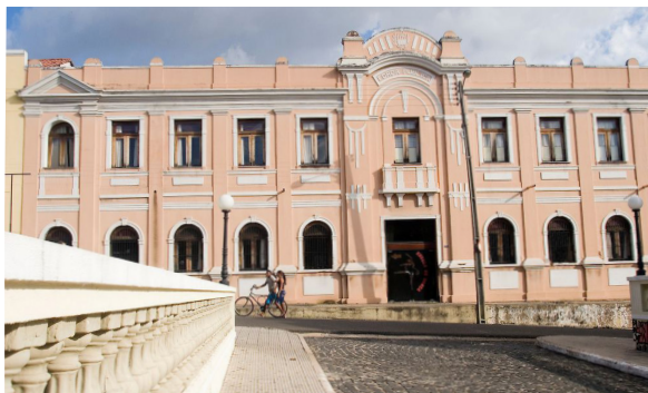
Figura 74 Antiguo Cuartel de Policía antes de la intervención. Fuente: Helter (2009).
