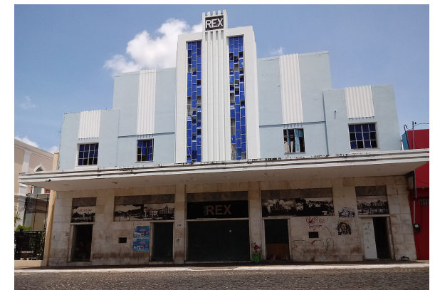
Figura 73 Cine Rex después de la intervención. Fuente: Ximenes (2020).
