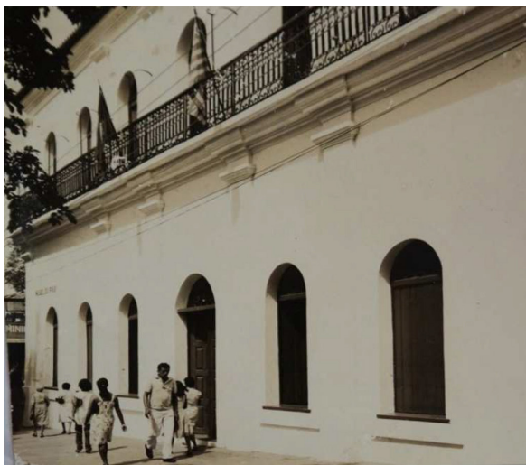
Figura 52 Imagen del edificio del Museo del Piauí en actividad en el año de 1980 muestra como han sido mantenidas sus características físicas y formales con la intervención. Fuente: Acervo Museológico Institucional (1980), tomado de Catarino (2017).
