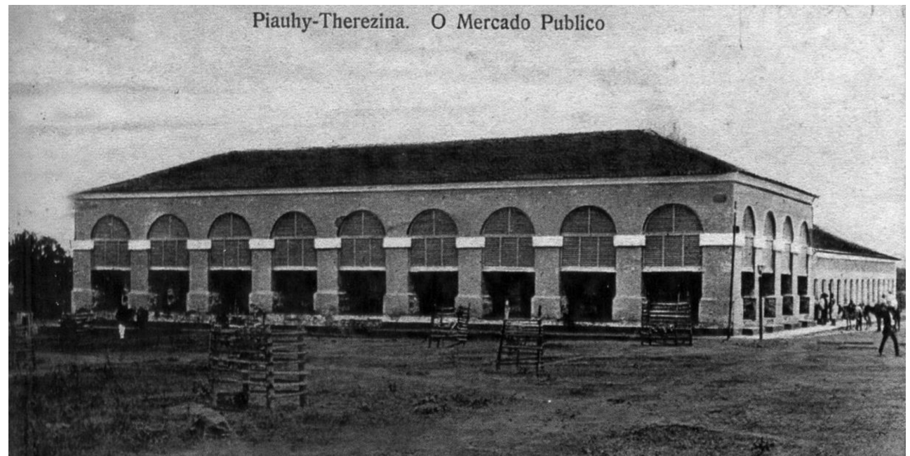
Figura 42 Edificio del Mercado Central San José a inicios del siglo XX, con su fachada arqueada y cubiertas en cuatro aguas. Fuente: Silva Filho (2007).
