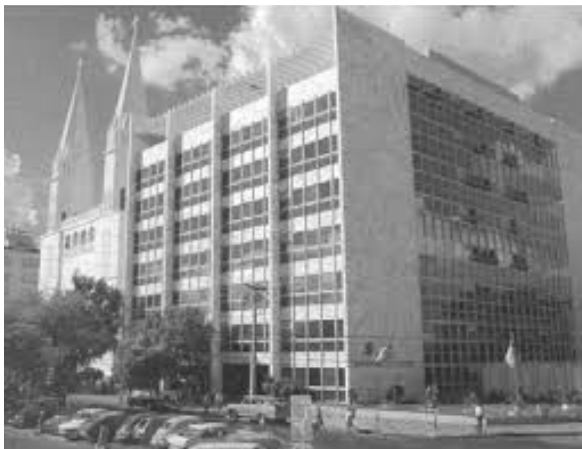
Figura 65 Imagen externa actual del edificio, que se evidencia en el paisaje por su altura y robustez, al lado de la Iglesia de Nuestra Señora del Amparo. Fuente: Araújo (s.f.).
