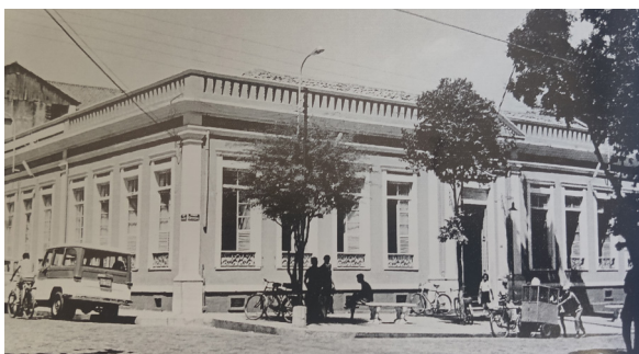
Figura 61 Registro de la década de 60. Se nota el edificio original y, al fondo en la izquierda, la nueva edificación con doble planta. Fuente: Gutemberg (2017).
