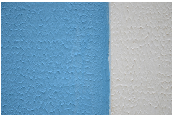
Figura 79 Textura aplicada a los muros del edificio sede de la Secult. Fuente: Autora (2020).
