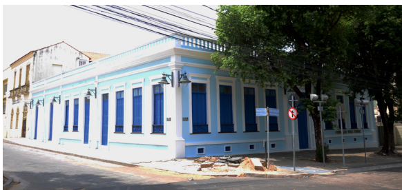
Figura 62 En reforma más reciente, ocurrida en 2013, el edificio recibió nueva pintura y se sustituyeron puertas y ventanas. Fuente: Autora (2020)
