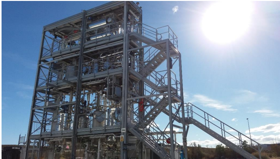
Figura 3.1. Vista frontal de la planta piloto de valorización de residuos plásticos.
