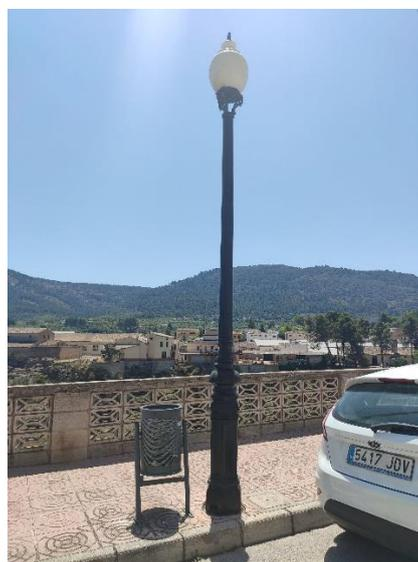
**Figura 19. Luminaria esférica sobre columna con bloque óptico opaco de 4 metros de altura**
