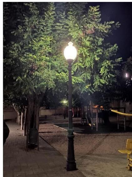
**Figura 17. Luminaria esférica sobre columna con bloque óptico opaco de 3 metros de altura diseño 1**
