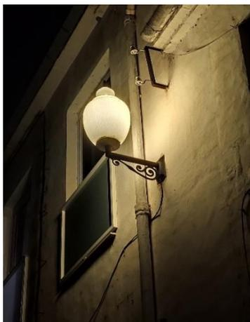
*Figura 13. Luminaria esférica directa a pared con bloque óptico opaco diseño 1*
