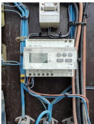
**Figura 34. Programador astronómico Orbis modelo Data Astro del sector 1**
