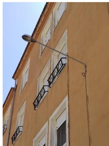
**Figura 11. Luminaria asimétrica tipo cazoleta con brazo de 2,2 metros de longitud**
