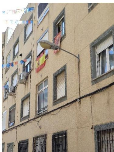
**Figura 12. Luminaria asimétrica con reflector**
