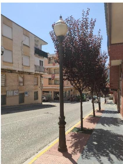
**Figura 18. Luminaria esférica sobre columna con bloque óptico opaco de 3 metros de altura diseño 2**
