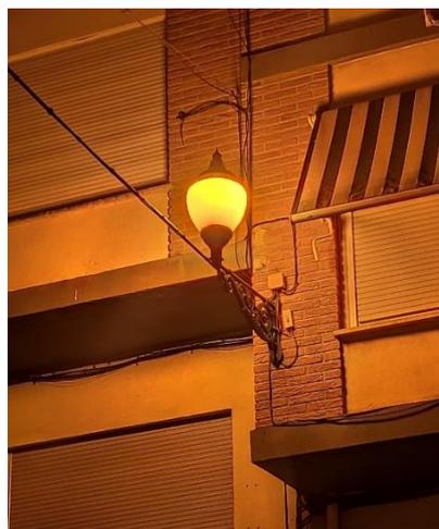
*Figura 15. Luminaria esférica directa a pared con bloque óptico opaco diseño 2*
