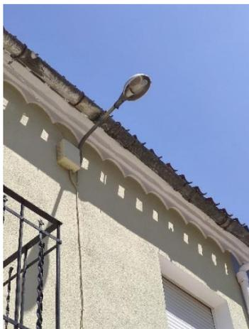
**Figura 10. Luminaria asimétrica tipo cazoleta con brazo de 1 metro de longitud**
