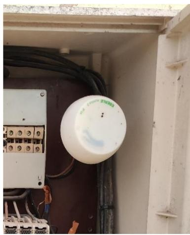
**Figura 30. Fotocélula instalada en el subcuadro del Passeig de la derrota**
