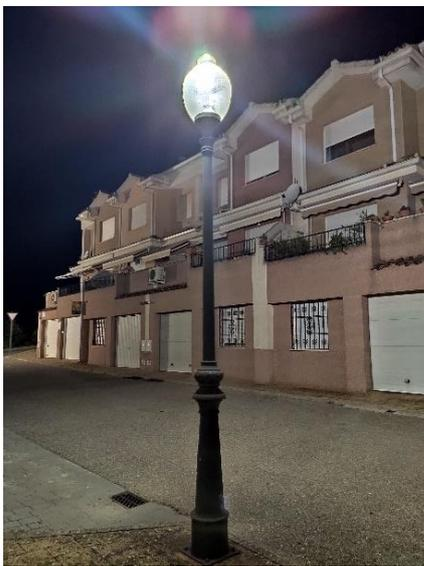
**Figura 16. Luminaria esférica sobre columna con bloque óptico transparente de 3 metros de altura diseño 1**
