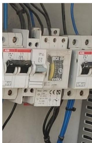
**Figura 35. Interruptor horario analógico Orbis modelo Inca Duo del sector 2**
