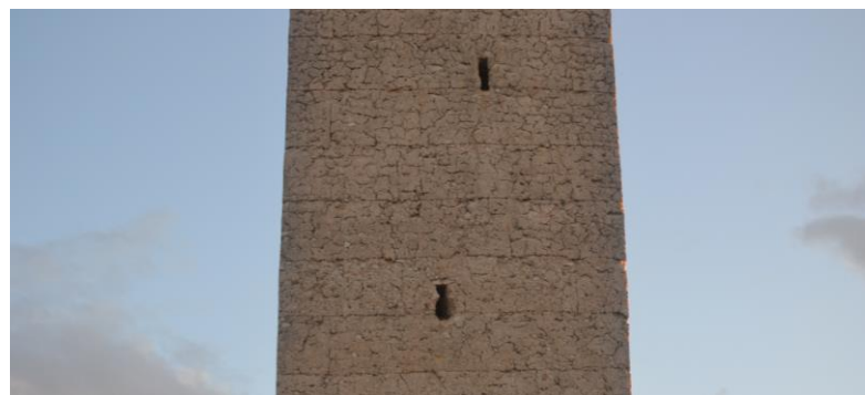
Fig 5. 2 Quartejat de la tàpia. Torre Espioca. Fotografia pròpia
