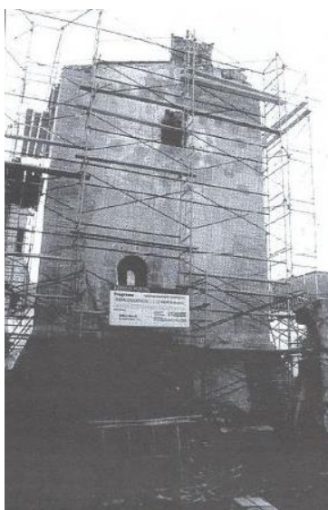
Fig 6. 12 Inici de les obres de restauració. E. Bosch, 1994: 54
