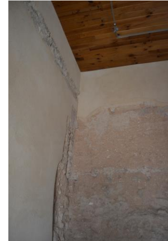
Fig 6. 7 Unió forjats amb murs. Detall de la tàpia. Fotografia pròpia
