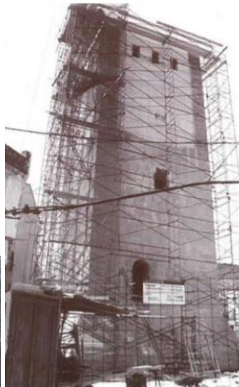
Fig 6. 15 Obres de restauració. Martínez, 1994,12
