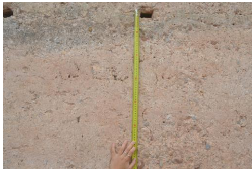
Fig 1. 6 Dimensions in situ de la tàpia. Torre Bofilla
