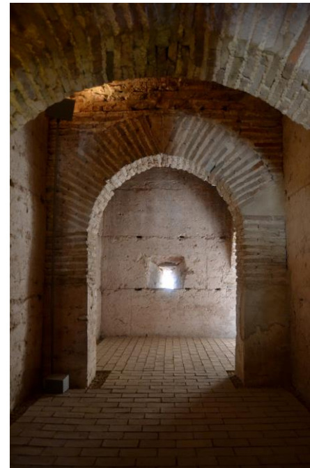
Fig 4. 12 Interior torre Benifaió
