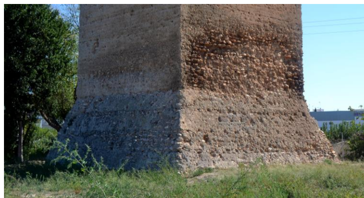
Fig 4. 2 Cimentació torre de la Ermita (Serra). Fotografia pròpia
