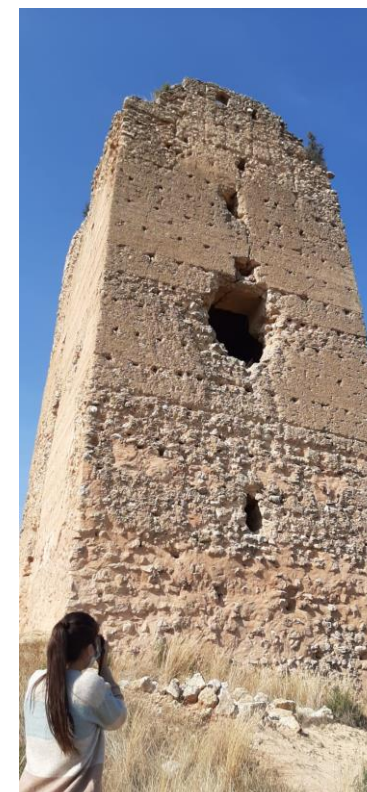
Fig 1. 3 Visita torre de Montroi
