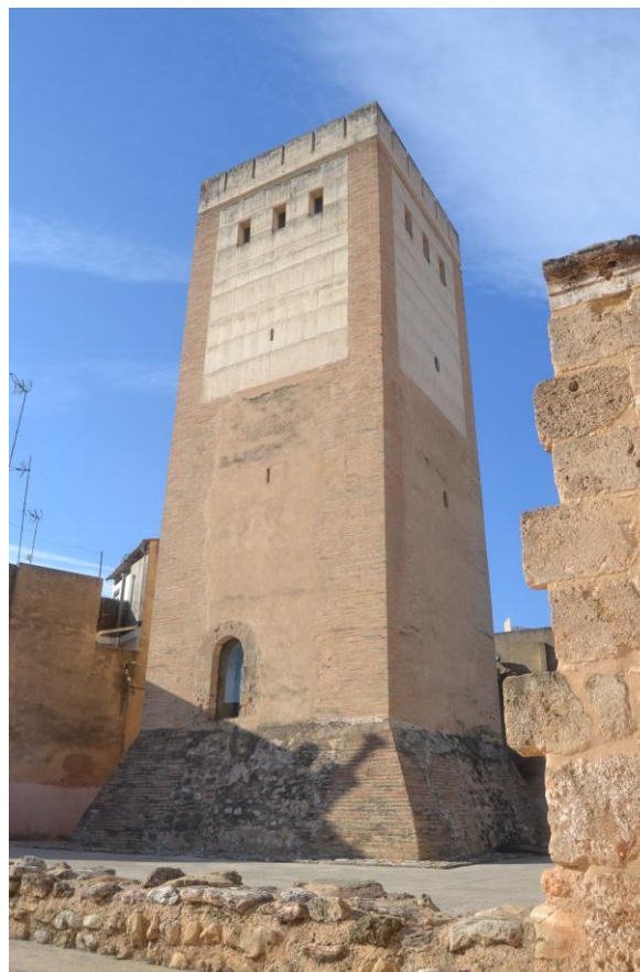
Fig 6. 10 Torre dels Borja de Canals. Fotografia pròpia
