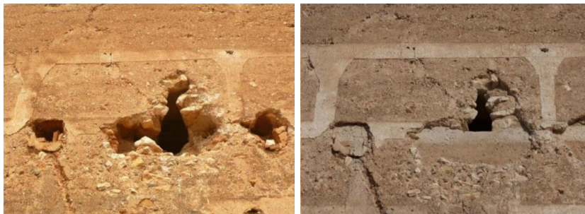
Fig 6. 27 Comparació estat inicial i actual de la tàpia i el revestiment decoratiu. Mileto i Vegas, 2010
