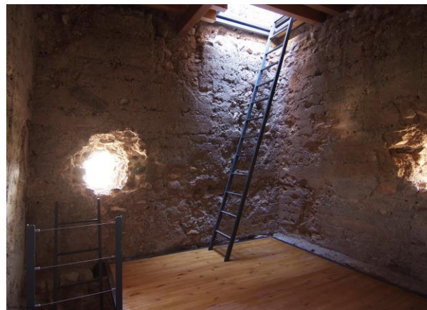
Fig 6. 26 Detall interior, estat actual. Mileto y Vegas, 2010
