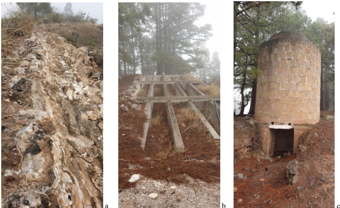
**Fig. 4 Canal (a) que conducía el agua de la galería al decantador (b) y horno (c)**
