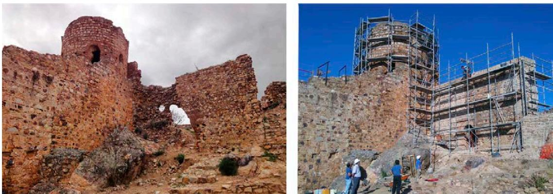
Fig. 5 Proceso de restauración y consolidación de las partes en riesgo de desaparición
