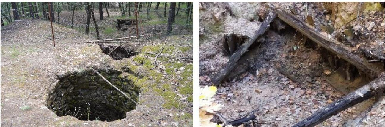
**Fig. 4** Izquierda, pozo mamposteo de ventilación del pozo Ángel. Derecha, aspecto actual del pozo Ángel. Como se puede observar, a pesar de encontrarse colmatado con tierra hasta su borde, se conserva la antigua entibación de madera. Obsérvese que las galerías que unen los dos pozos están colapsando
