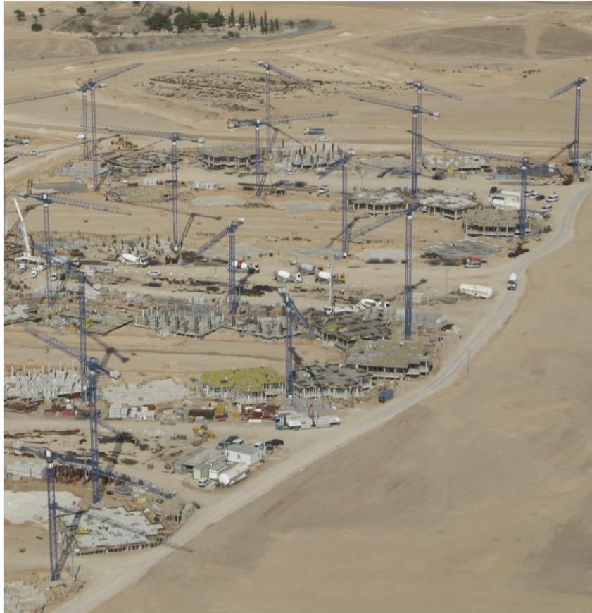
FIGURA 39: OBRA EN FASE DE ESTRUCTURA. (GIL SÁNCHEZ, A., 2006)
