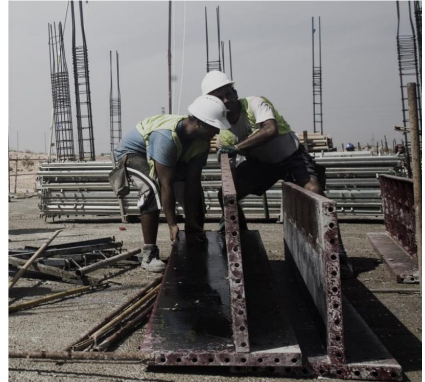
FIGURA 19: IMAGEN ALBAÑILES TRABAJANDO. (GIL SÁNCHEZ, A., 2006)
