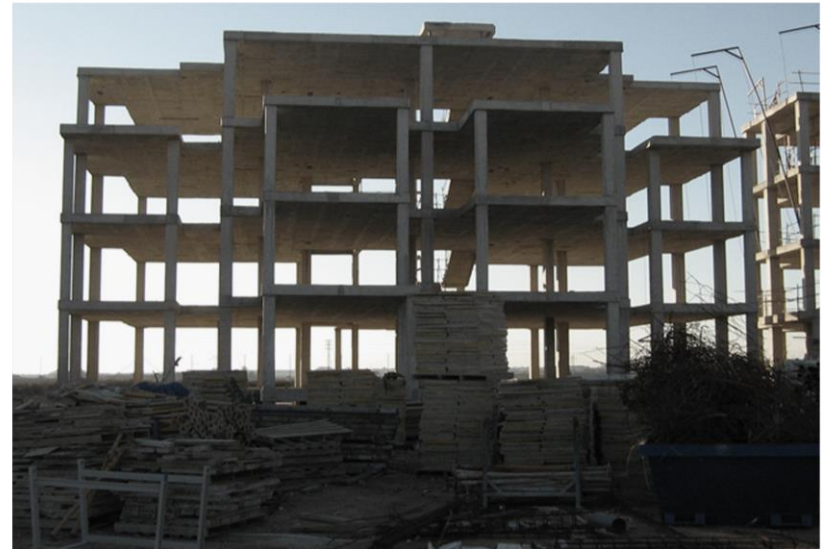
FIGURA 40: IMÁGENES DEL EDIFICIO EN FASE ESTRUCTURAL. (GIL SÁNCHEZ, A., 2006).
