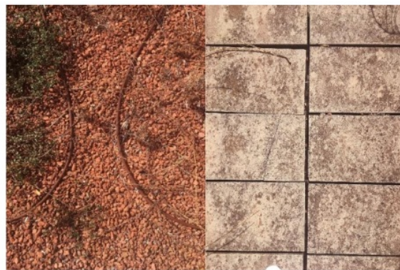
Imagen 34. Fotografías de detalle de la cubierta 3. A la izquierda, zona de grava y a la derecha zona pavimentada de piedra de color beige. Elaboración propia
