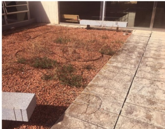
Imagen 33. Fotografía general de la cubierta 3. Elaboración propia
