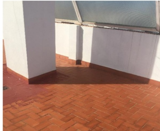
Imagen 44 Fotografía general de la cubierta 4. Elaboración propia
