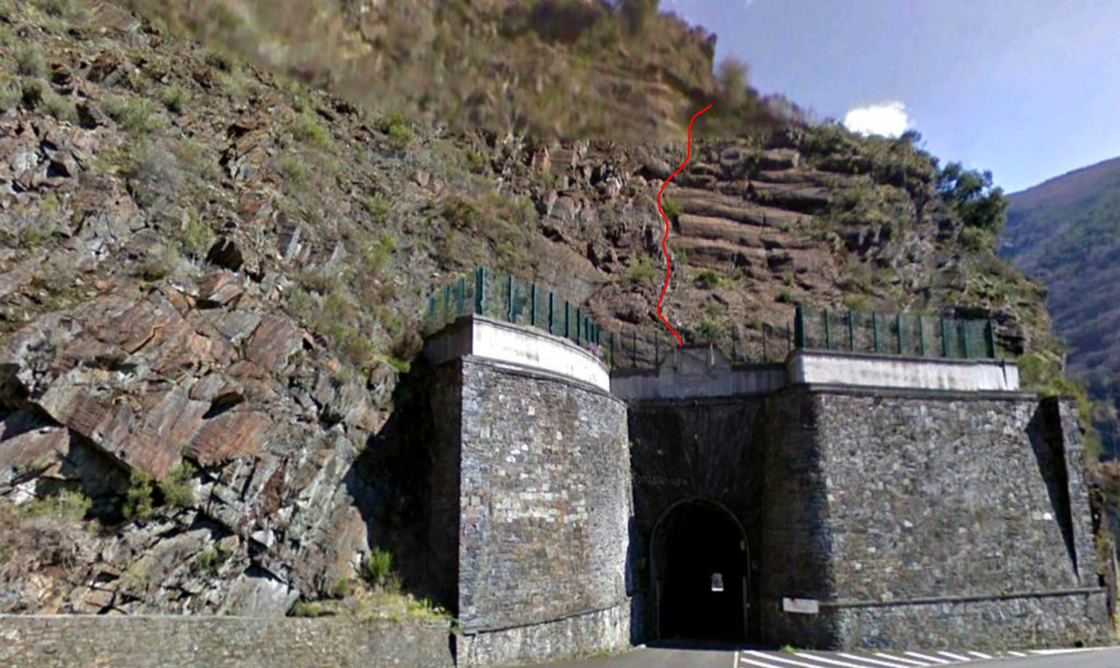
Túnel revestido en zona de coronación. Pizarras negras (P. de Luarca) Ordovícico Med. Estribo izquierdo -W- Embalse de Salime. Asturias. SW Hoja de Cangas de Narcea
