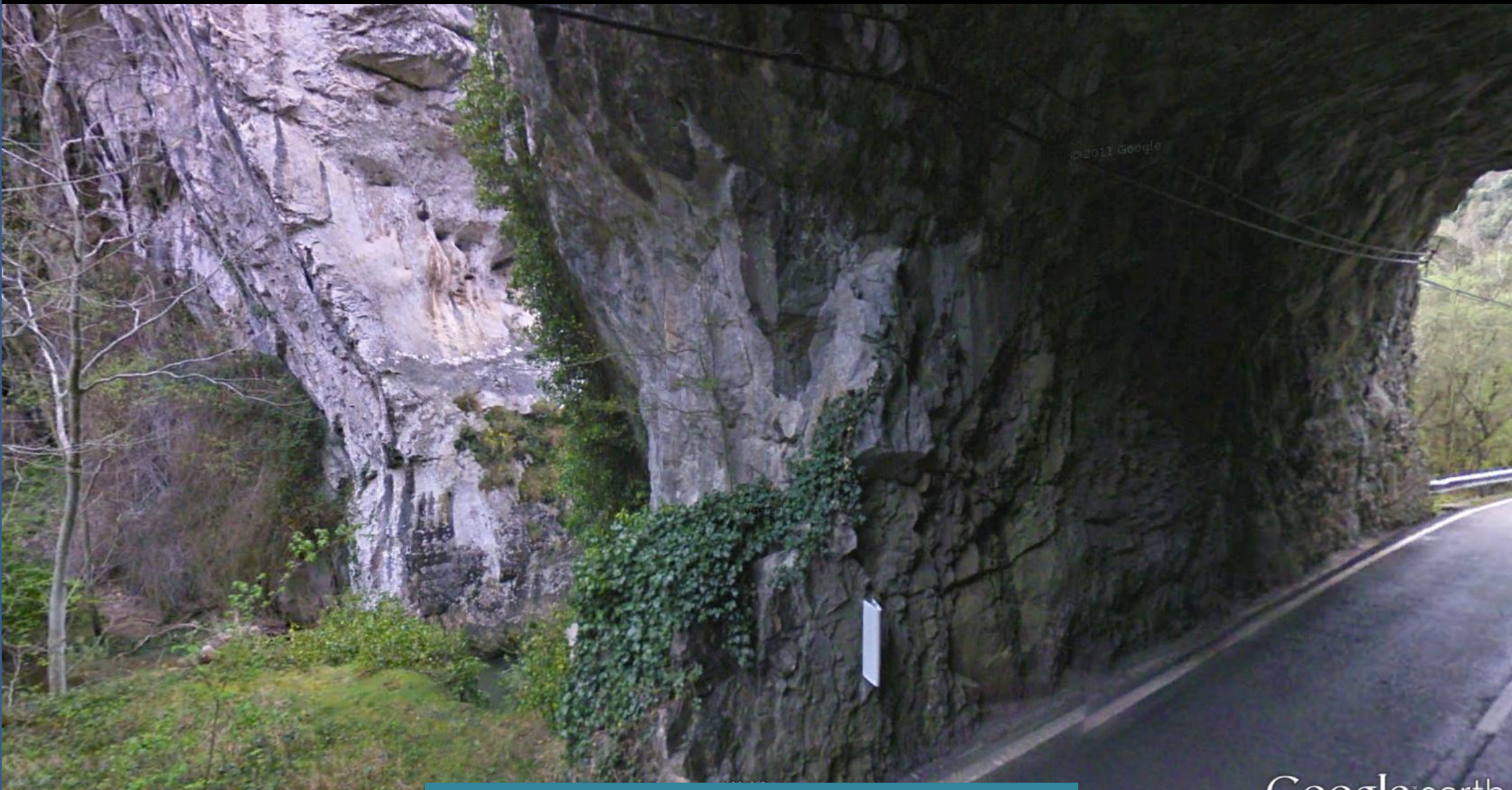
Detalle de anterior: Túnel no revestido en las calizas del Carbonífero del barranco del Río Somiedo. S de Castro, Asturias. NE Hoja de Pola de Somiedo
