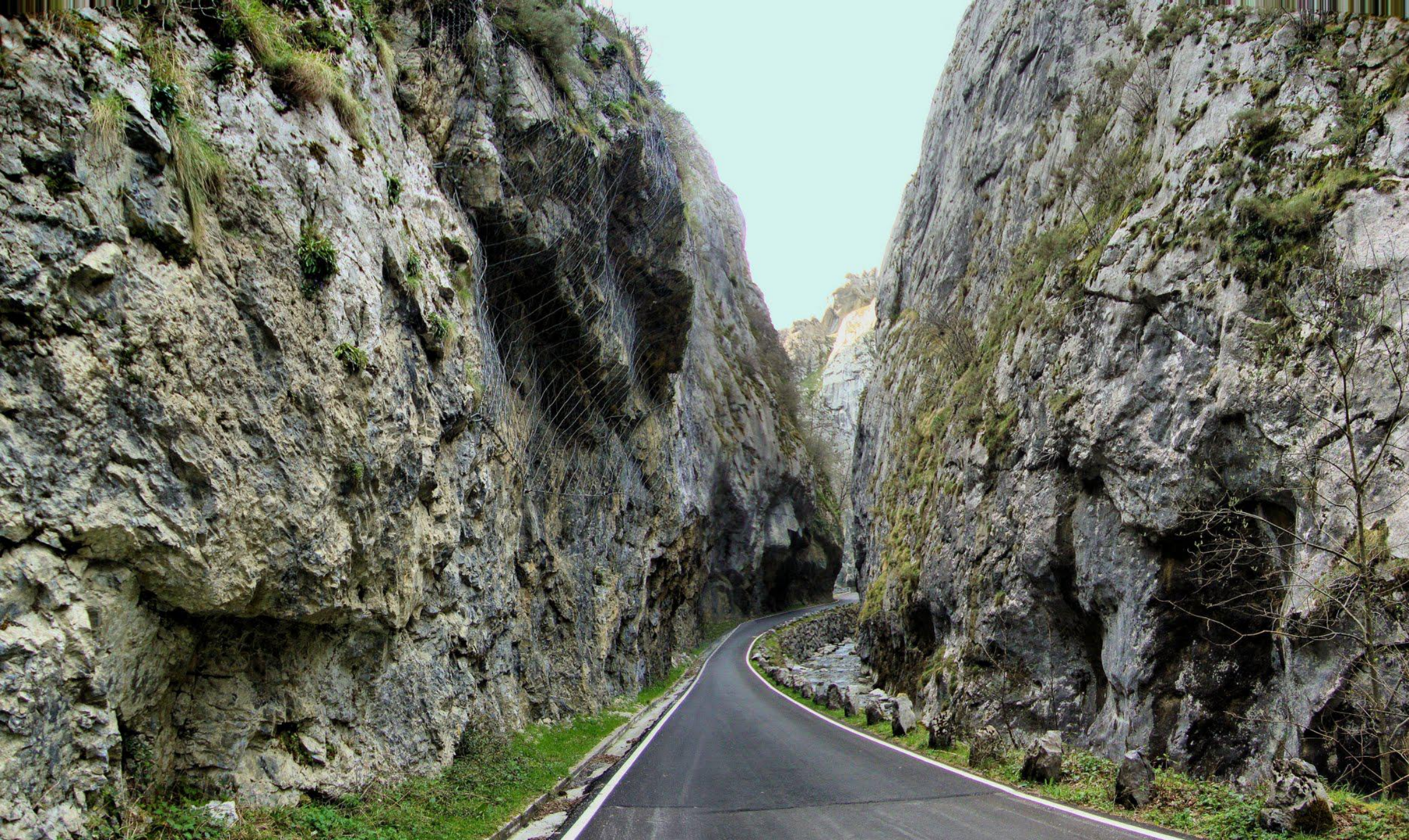
Malla protectora en las calizas masivas del Westfaliense, Carbonífero Sup. En las Hoces del Río Aller. Casomera, Asturias. SE Hoja de Pola de Lena. (por Papulandia-Google)
