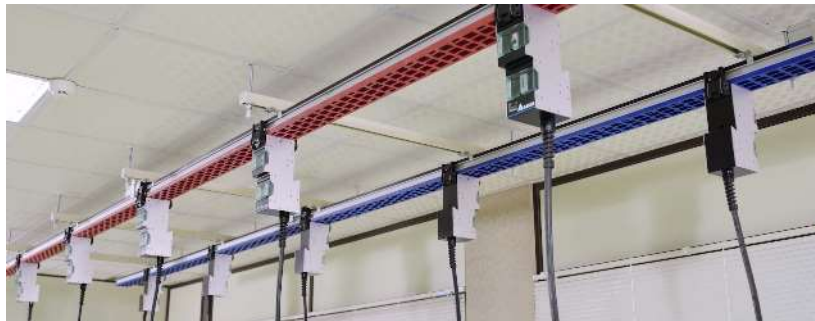
Imagen 30. Soluciones tipo busbar.
