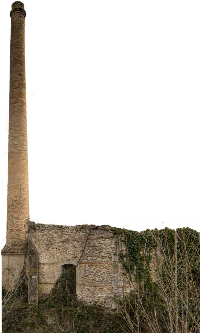
En el alzado norte se diferencian con claridad cinco cuerpos, el del molino harinero, el del volumen de la rueda hidráulica, el volumen principal, el destinado a contadores y en un plano más próximo al río está el volumen de la caldera de vapor.
