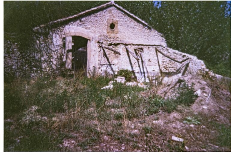
terminación en teja curva para seguir el acabado original. La conexión estructural de las dos cubiertas, la original y la actual, son distintas entre sí a pesar de ser las dos a dos aguas. En la cubierta original, la cumbrera descansaba sobre las jácenas y que estas al mismo tiempo y al igual que las jácenas de las plantas inferiores, reposa sobre los pilares. A estas jácenas se les apoyaban las vigas de madera y los tableros, descansando en el otro extremo de la viga en los muros.
