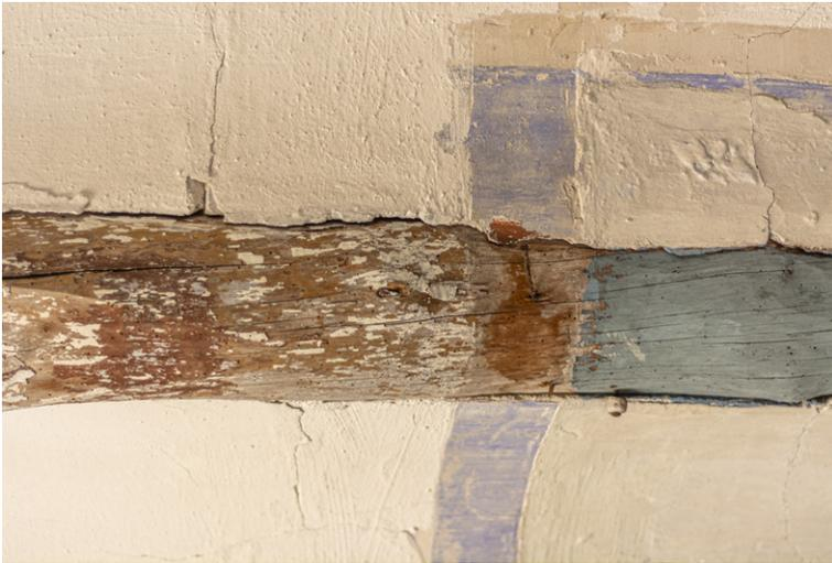
separación de 60 centímetros entre ejes. El revoltón es de ladrillo cerámico con unas dimensiones de 14,5 centímetros de ancho, 2,5 centímetros de alto y 29,5 centímetros de largo. El acabado del revoltón es enlucido de yeso, hay pintura sobre la madera.
