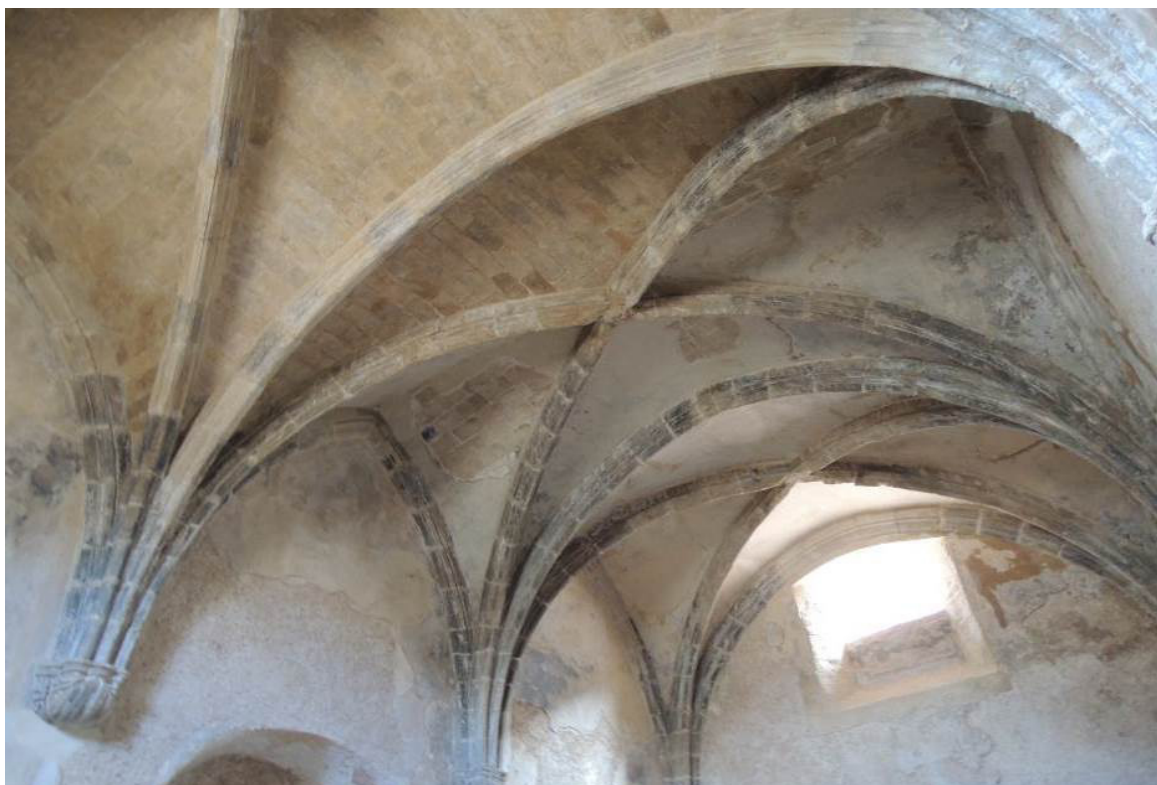
Fig. 47. Interior de la Capilla. Detalle de la bóveda de crucería ojival y nervios de yeso, 2014.
