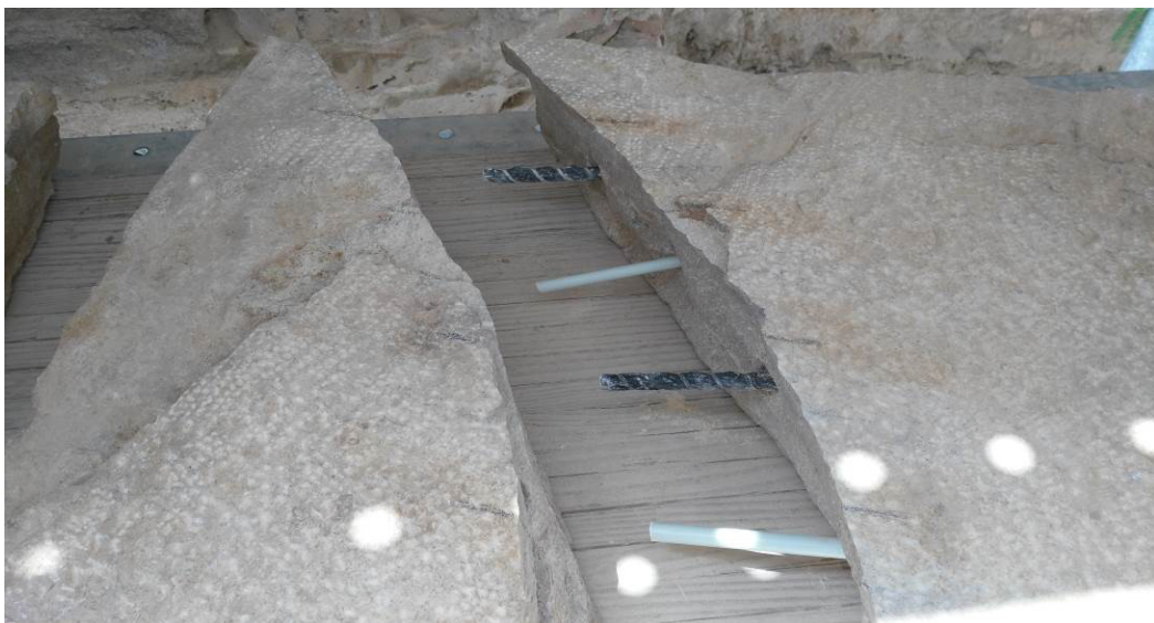
Fig. 25. Cosido de fractura de una lápida en Convento de San Francisco de Vinaroz,2015.NOEMA RESTAURADORES SL
