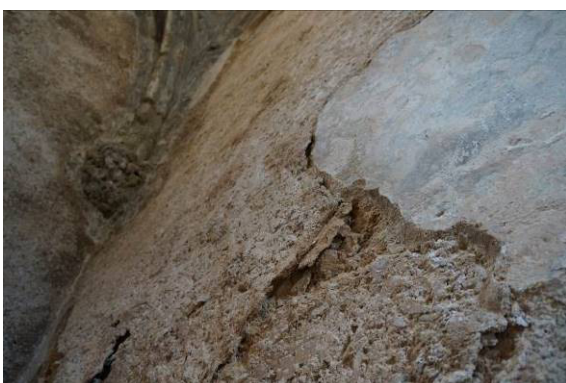
Fig. 57. Detalle del mortero de revestimiento del soporte y mortero fino de cal, 2015.
