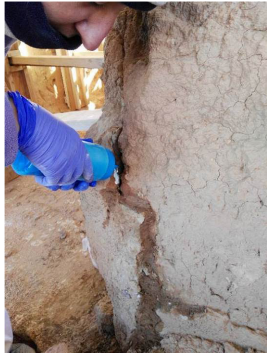
Fig. 90. Proceso de sellado de grietas y aplicación de mortero de inyección de cal hidráulica natural, 2017.
