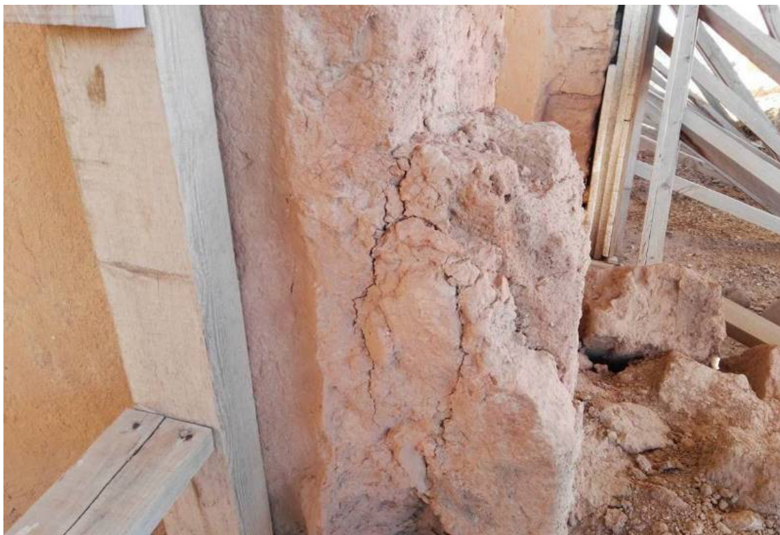
Fig. 89. Detalle. Inicio del sellado de grietas, 2017.
