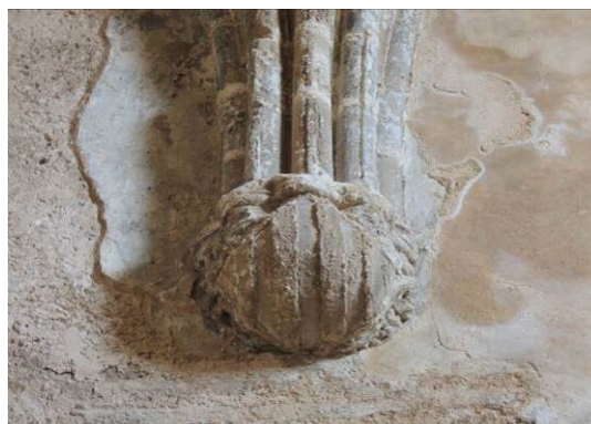
Fig. 56. Detalle de una ménsula de yeso y de los morteros de revestimiento. Afloración de agregados cristalinos y manchas de carbonatación en los revestimientos, 2015..
