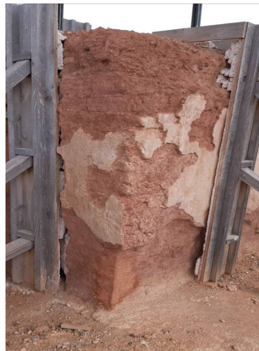
Fig. 117. Después de su intervención en 2019. 2020.
