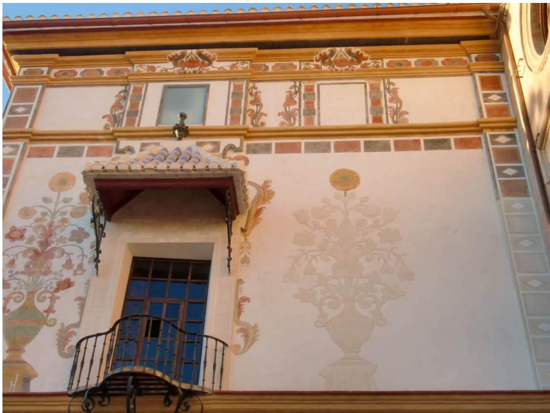
Fig. 28. Reposición del revestimiento continuo de la fachada norte del Palau Ducal de Gandía, 2011. NOEMA RESTAURADORES SL
