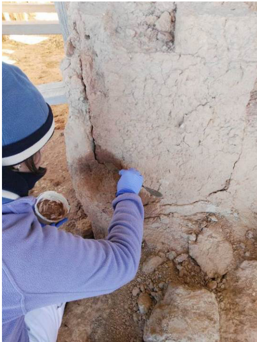
Fig. 90. Proceso de sellado de grietas y aplicación de mortero de inyección de cal hidráulica natural, 2017.
