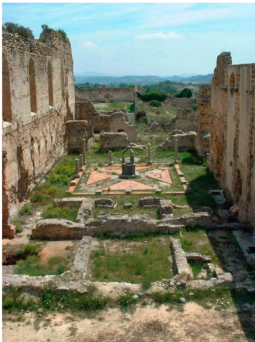
Fig. 134. Claustro de San Jeroni tras su intervención. Imagen de Josep Marí Gómez Lozano.
