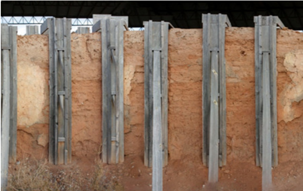
Fig. 97. Extremo sur del Gran edificio de adobe donde se inició la 1ª fase de consolidación y estudio de sus fábricas, 2018. NOEMA RESTAURADORES SL.
