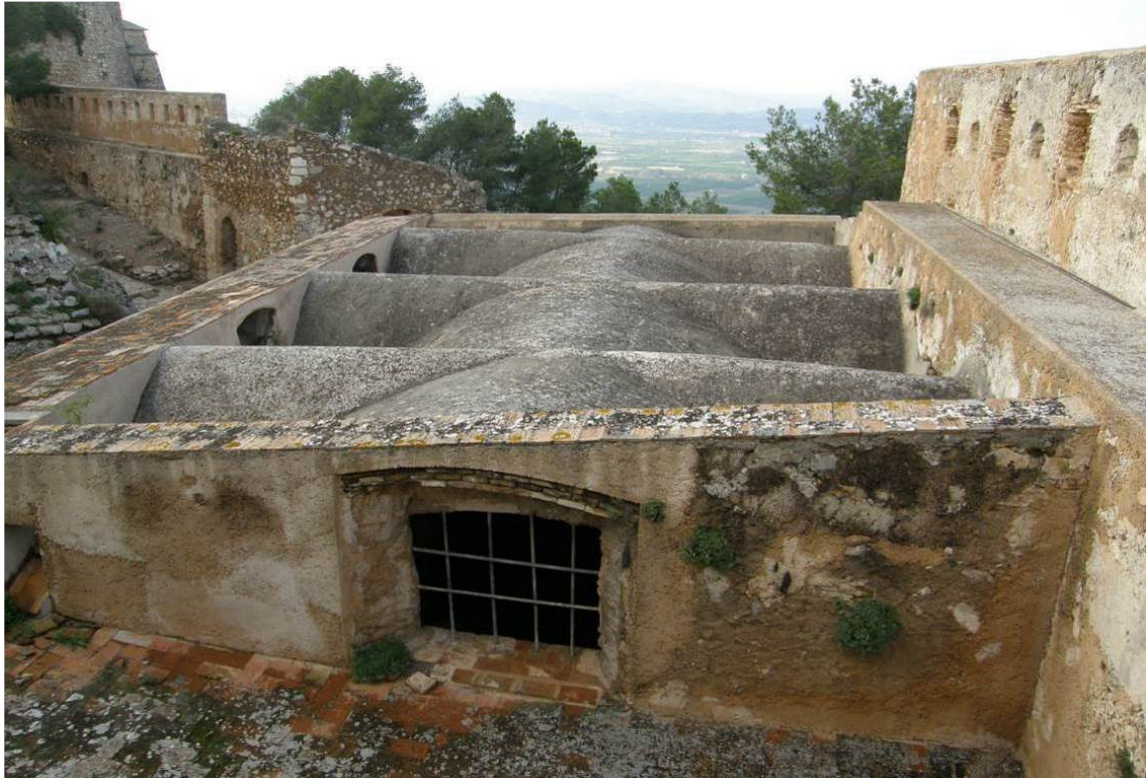
Fig. 54. Vista general de la terraza y cubierta de la capilla. Detalle de la ventana, 2009. Fotografía de V. Torregrosa
