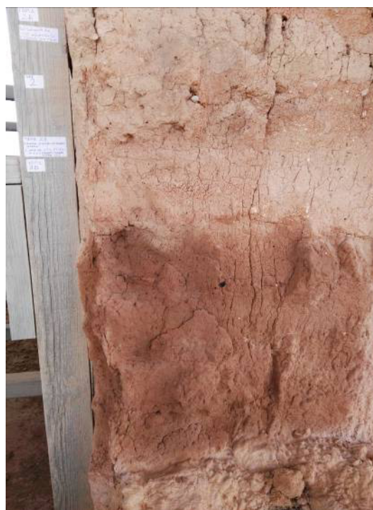
Fig. 83. Detalle de la señalización del lugar de las pruebas de campo, 2017. NOEMA RESTAURADORES SL
