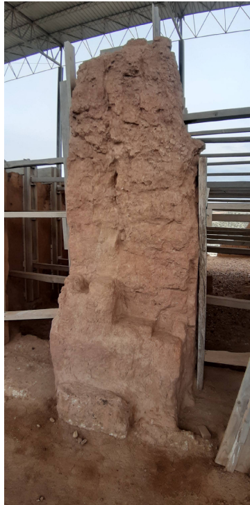
Fig. 114. Después de su intervención, en 2019. 2020.
