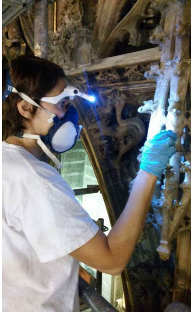
Fig. 17. Pruebas de limpieza. Retablo de alabastro de Antoni Dalmau de la capilla del Santo Cáliz de la catedral de Valencia, 2017. NOEMA RESTAURADORES SL
