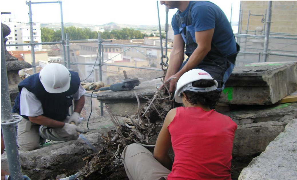
Fig. 26. Extracción de las raíces de una higera en uno de los contrafuertes de la Seo de Santa María de Xátiva, 2006.NOEMA RESTAURADORES SL
