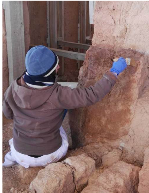
Fig. 95. Vista general del proceso de consolidación externo, 2017. NOEMA RESTAURADORES SL
