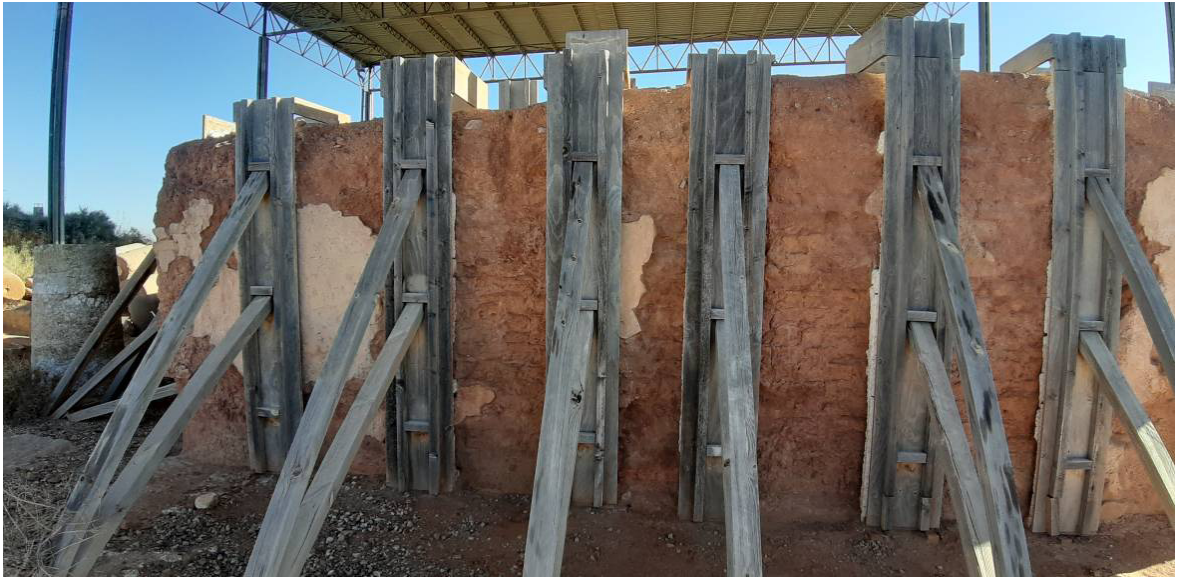
Fig. 110. Anverso y reverso del muro de adobe del denominado Gran edificio de adobe tras 14 meses de haber sido intervenido con trabajos de consolidación y restauración, 2019. NOEMA RESTAURADORES SL.
