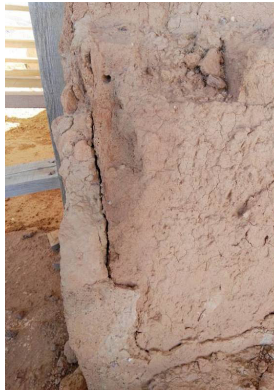
Fig. 88. Tapia 2. Vista en detalle antes de los trabajos de consolidación, 2017.
