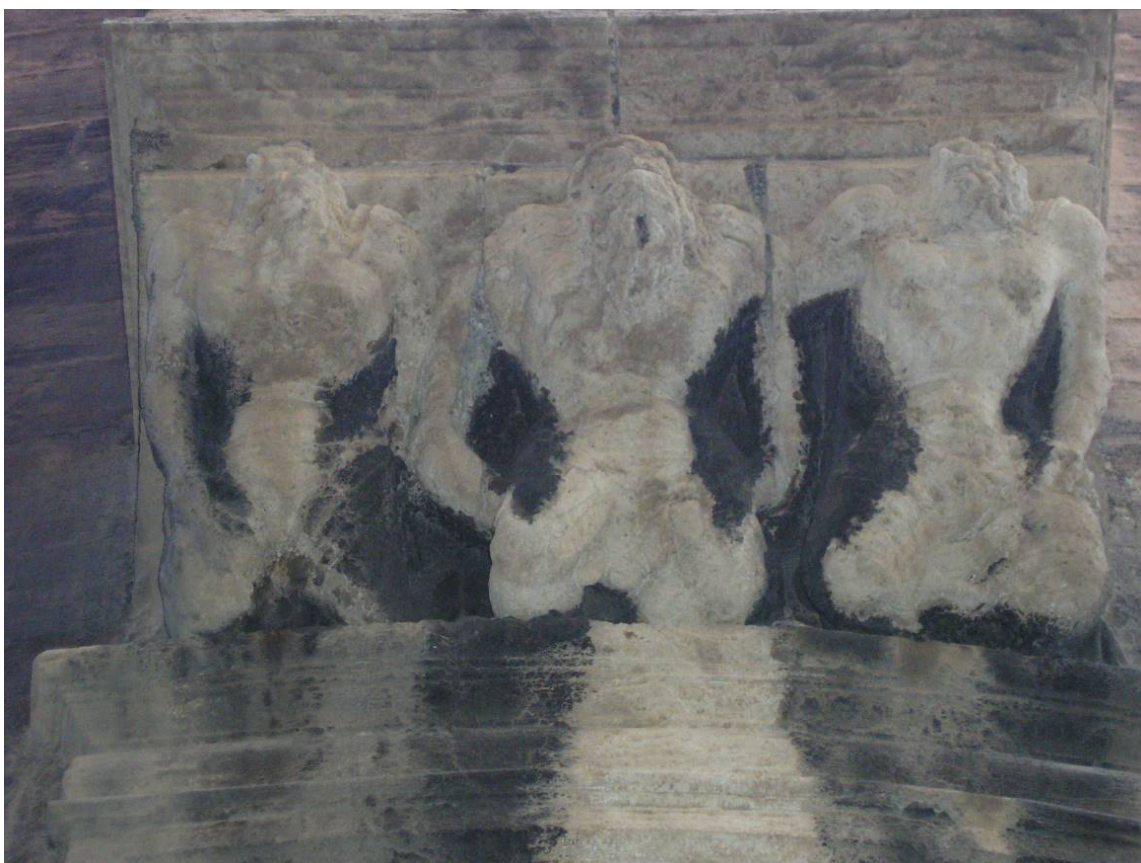
Fig. 36. Costra de sulfatación. Ménsula atlantes de la Iglesia de San Martín de Valencia, 2008. NOEMA RESTAURADORES SL
