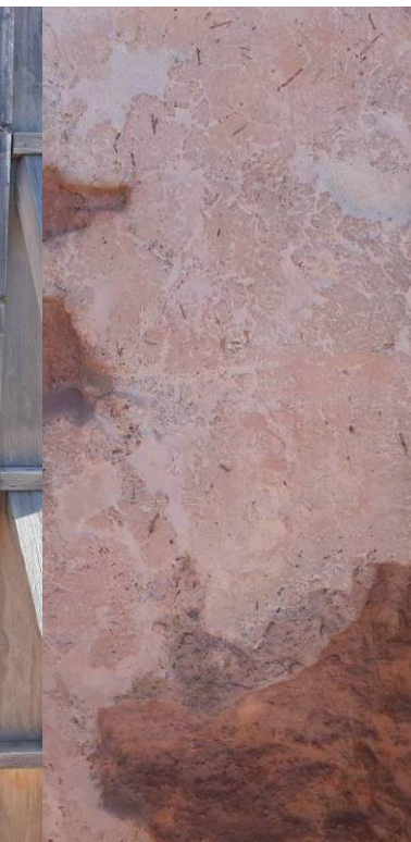
Fig. 124. Fragmento de revestimiento de cal después de su intervención, 2019. Imagen de 2020
