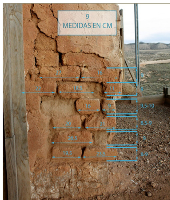
Fig. 102. Cartografías de identificación de materiales, 2018. NOEMA RESTAURADORES SL
