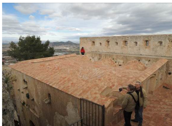
Fig. 64. Cubierta de la capilla tras su restauración. Fotografía realizada en 2015.
