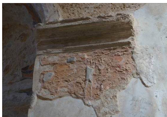
Fig. 56. Detalle de una ménsula de yeso y de los morteros de revestimiento. Afloración de agregados cristalinos y manchas de carbonatación en los revestimientos, 2015..
