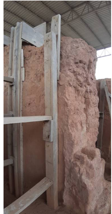
Fig. 115. Después de su intervención en 2019, detalle. 2020
