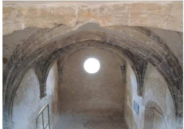
Fig. 66. Interior de la capilla tras su restauración. Fotografía realizada en 2015.
