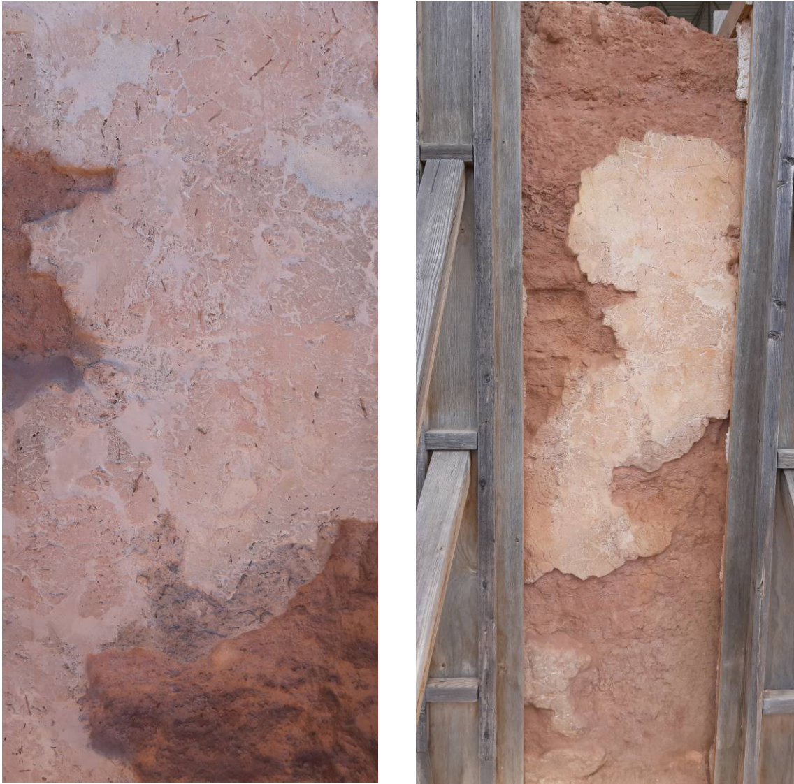
Fig. 112. Detalle de revestimiento original intervenido transcurridos 14 meses desde la actuación de conservación y restauración, 2019. NOEMA RESTAURADORES SL.
