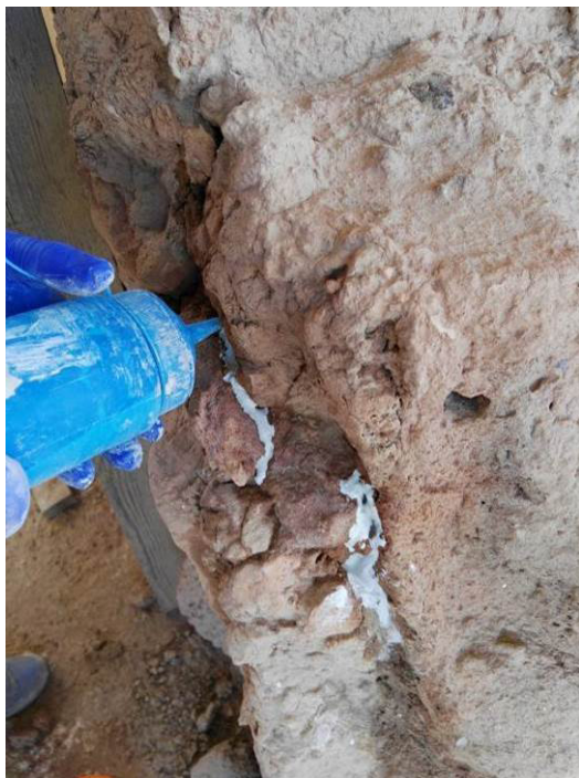
Fig. 92. Proceso de sellado
