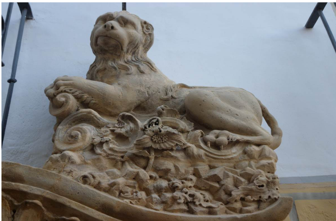
Fig. 29. Aplicación de una pátina de cal sobre escultura ornamental de la fachada del Palacio del Arzobispo Mayoral de Xàtiva, actual Museo de Bellas Artes, 2013. NOEMA RESTAURADORES SL.
