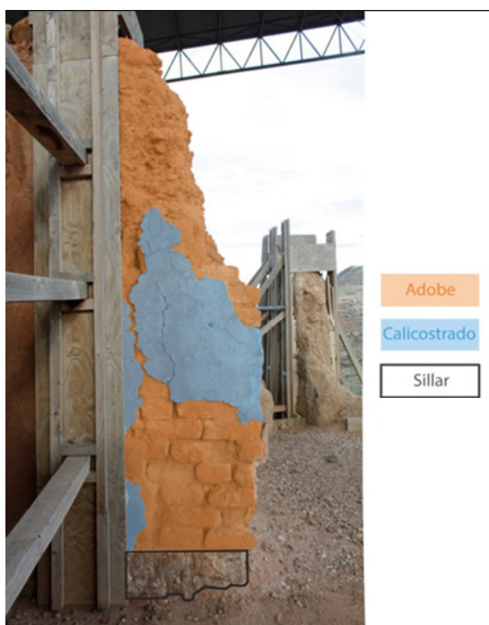
Fig. 101. Cartografías de identificación de materiales, 2018. NOEMA RESTAURADORES SL.
