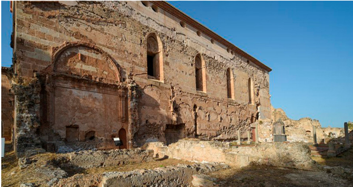
Fig. 133. Fachada meridional de la Iglesia Mayor, 2019.
