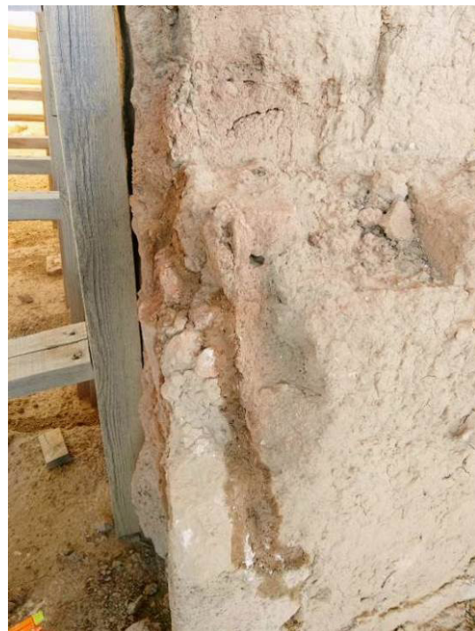
Fig. 93. Sellado efectuado
