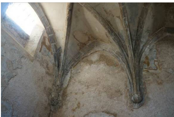
Fig. 55. Vista del interior de la capilla en la actualidad, 2015.
