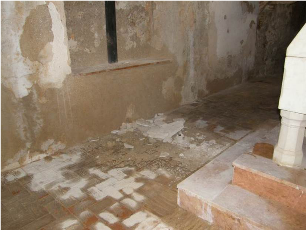
Fig. 52. Caída de cascotes bóveda. Obsérvese el suelo completamente mojado.2009. Fotografía de V. Torregrosa
