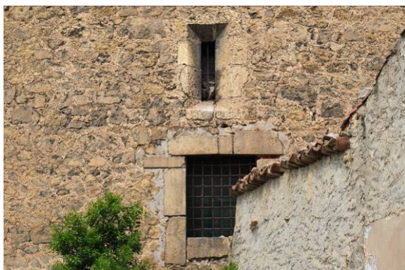
Fig. 6. Mampostería y sillería (Aras de los Olmos), 2019.
