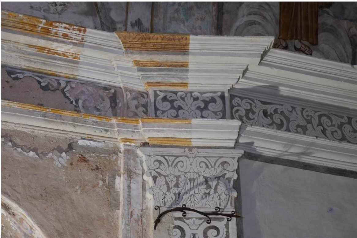
Fig. 3. Detalle del capitel restaurado de la pilastra que enmarca el presbiterio. Iglesia de Santiago de Benicalaf, 2019.Noema Restauradores SL
