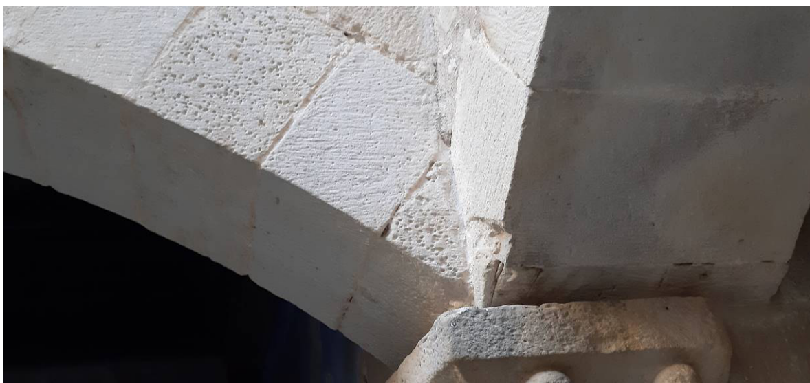
Fig. 31. Proceso de punteado. Santuario de San Joan de Penyagolosa, 2020. NOEMA RESTAURADORES SL
