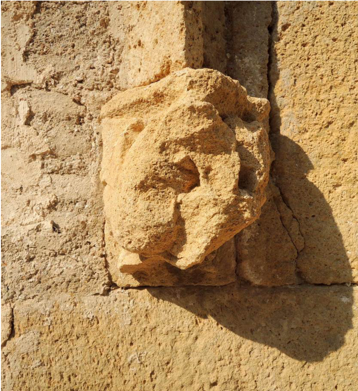
Fig. 42. Ménsula de piedra arenisca de Benigànim, en el alfiz de la portada de Santa María del castillo de Xàtiva
