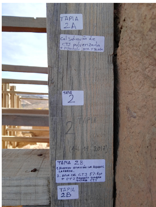
Fig. 82. Detalle de la señalización del lugar de las pruebas de campo, 2017. NOEMA RESTAURADORES SL
