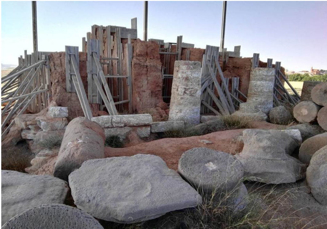
Fig. 75. Detalle del Gran edificio central con los apeos de madera colocados también en 1993.
