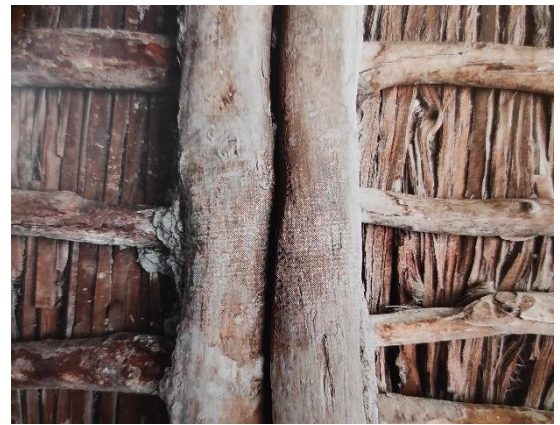
Imagen 52 y 53: forjados con estructura de madera
