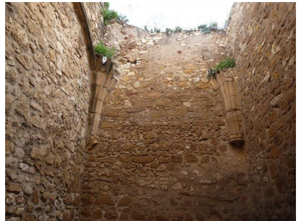
Imagen 50: muro de piedra con mortero de tierra
