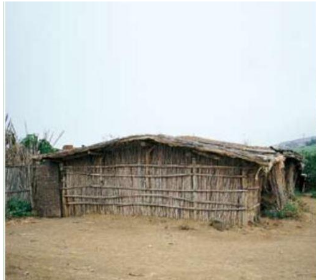
Imagen 32: foto exterior casa elemental en la región de Ouarsenis , Argelia.
