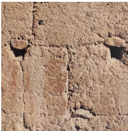
Imagen 47: muro de tierra
