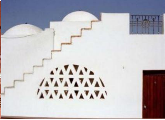
Imagen 24: sistema de ventilación por huecos
