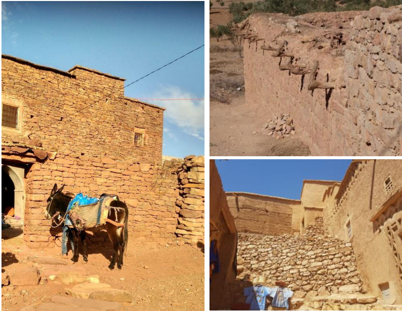
Imagen 70, 71 y 72: muro de piedra-Marruecos.
