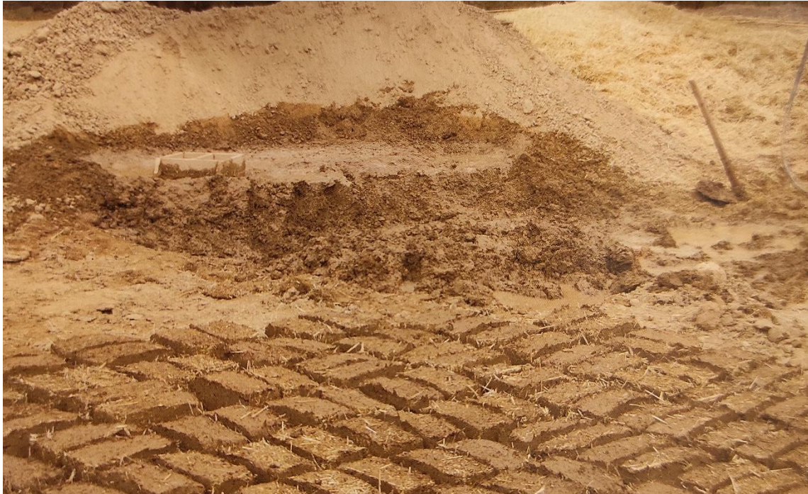
Imagen 66: la fabricación de adobes
