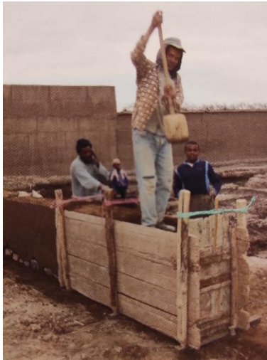
Imagen 57: ejecución de una tapia Imagen 58: esquema de tapial
