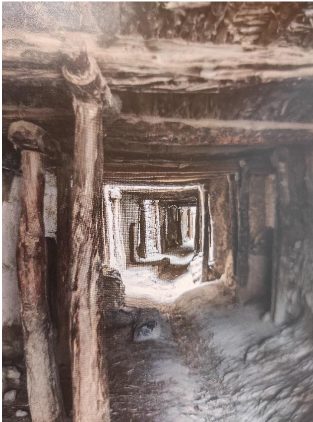
Imagen 51: calle típica de kser,estructurs de madera
