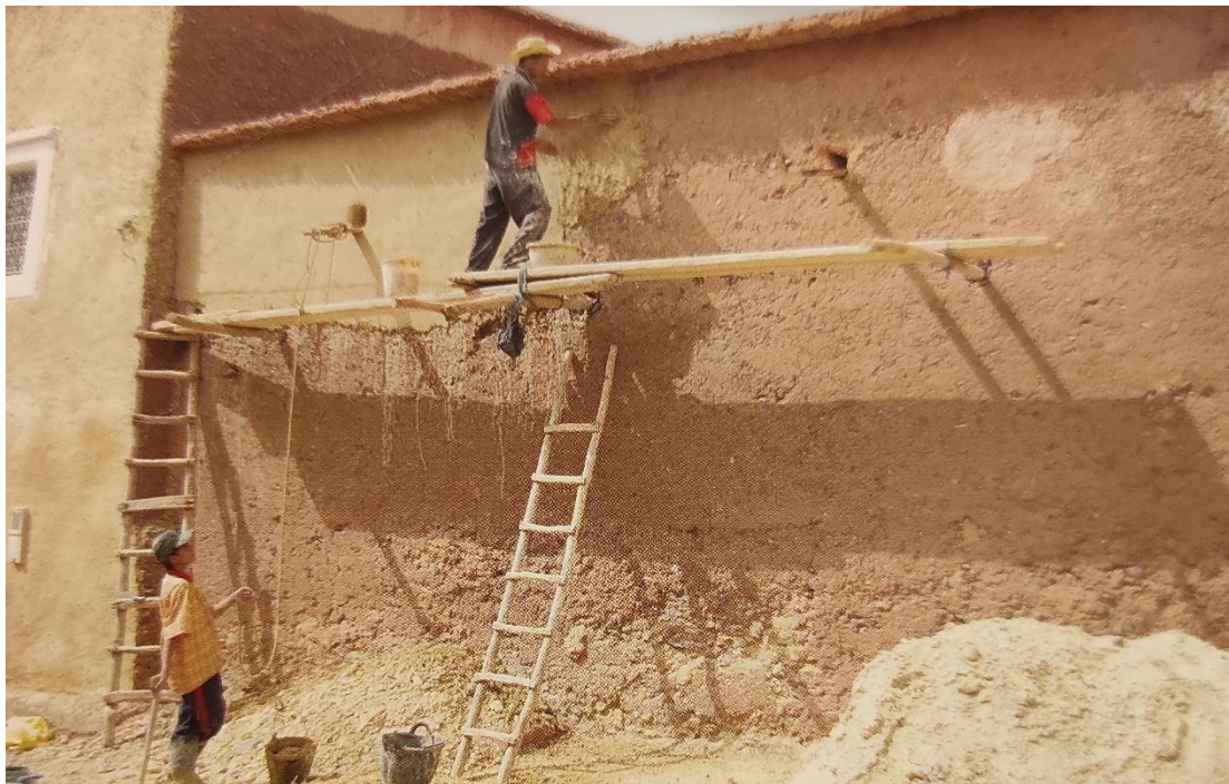
Imagen 59: recubrimiento de la tapia con mortero de tierra y paja después del secado
