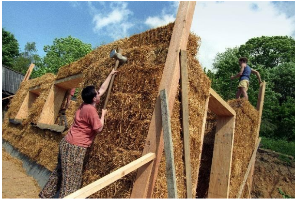
Imagen 54: construcción con paja
