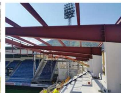
Fig. 58. Estructura cubierta
