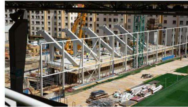
Fig. 132. Costillas hormigón armado prefabricado
