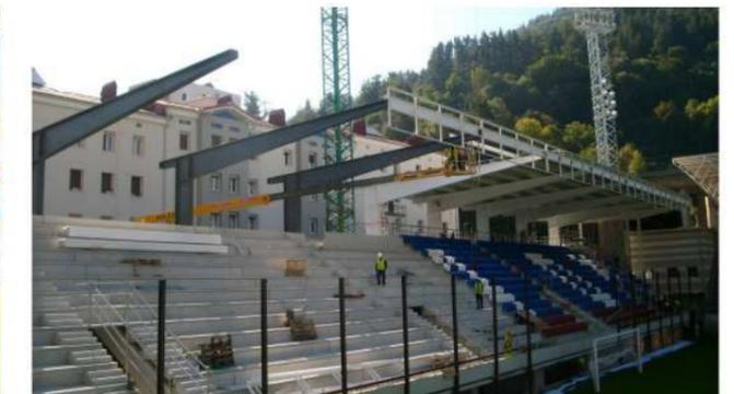
Fig. 124. Cubierta Tribuna Este en construcción
