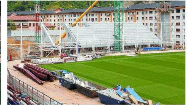
Fig. 133. Colocación módulos de la grada
