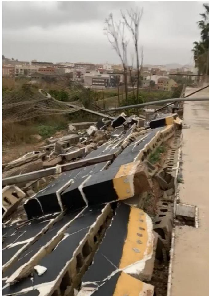
Ilustración 7. Estado del muro tras el tornado. (Fuente: Esportsbase media)
