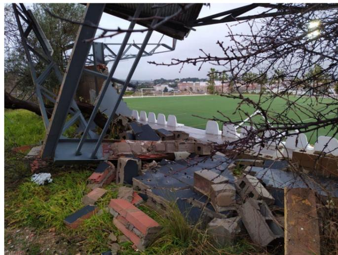
Ilustración 1. Estado de la grada tras el tornado. (Fuente: Periódico Bandú Ceste).
