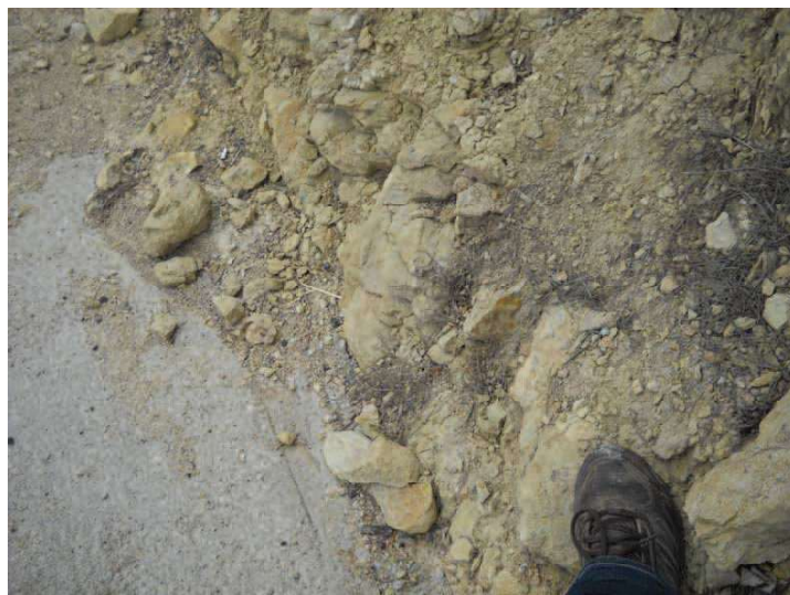
Foto n° 32: Talud P.K. 1+200, Particular
