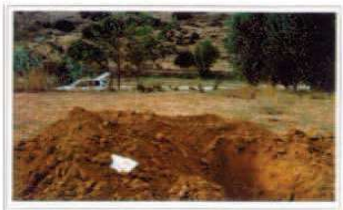
Foto 7: Acopios calicata n° 3.
