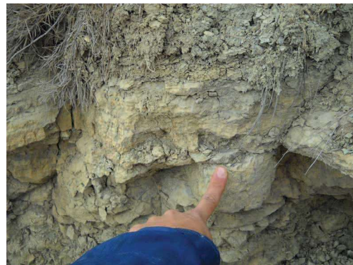
Foto n° 30: Talud P.K.1+230, Particular
