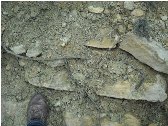
Foto nº 16: Talud P.K.0+580 (Particular)
