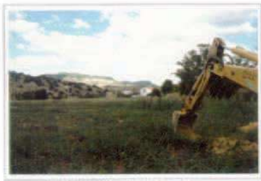
Foto 1: Situación de la calicata n° 1.
