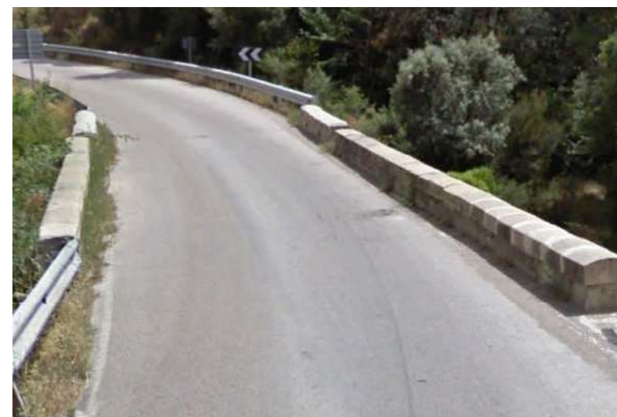
Imagen de la plataforma existente
