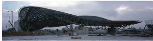
Construcción del Pabellón Olímpico de Londres, Zaha Hadid
