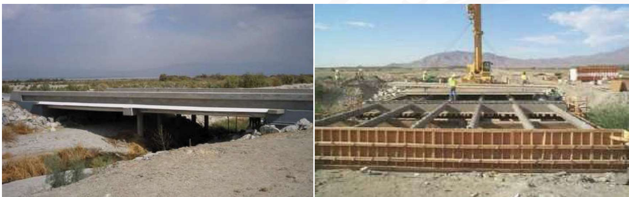
Figura 4.2 _ Imágenes de la construcción del Kings Stormwater Channel Bridge.
