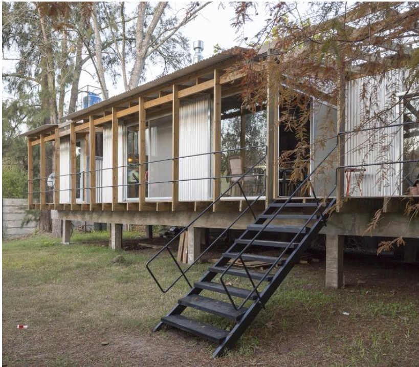
Fig. 136 Casa Dique Luján – Escalera de acceso
