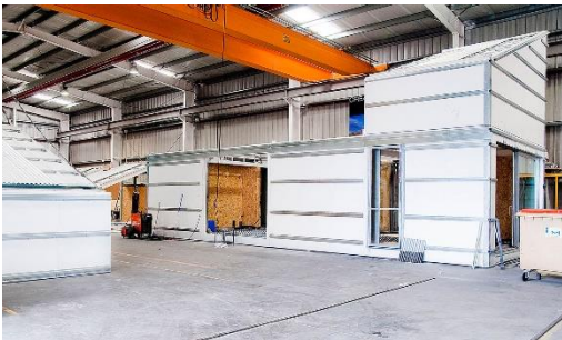
Fig. 232 Casa Garoza - Construcción en taller
