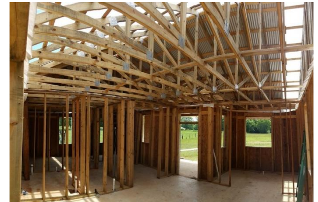
Fig. 193 Buster's Home - Casa en construcción
