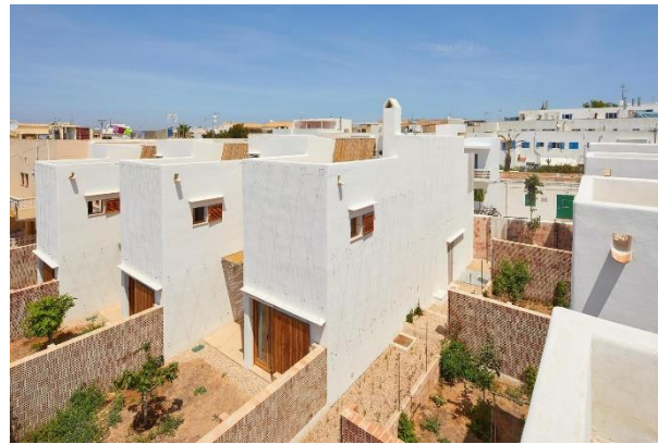
Fig. 241 VPP de Sant Ferran - Vista aérea
