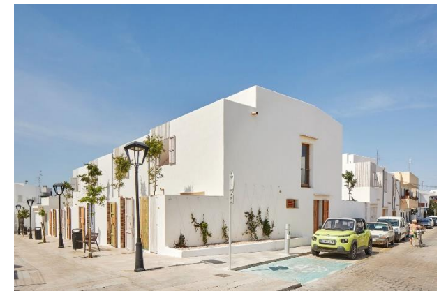
Fig. 239 VPP de Sant Ferran - Esquina
