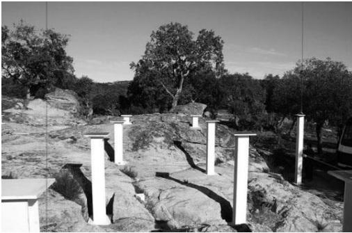
Fig. 235 Casa Garoza - Pilares en la roca
