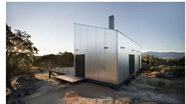
Fig. 222 Casa Garoza - Esquina noroeste
