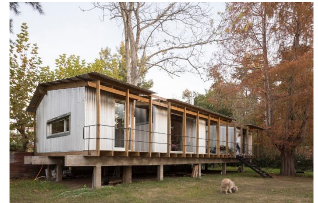
Fig. 125 Casa Dique Luján – Esquina norte
