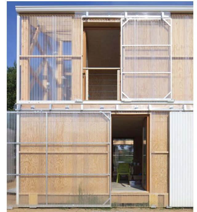
Fig. 204 Maison D. – Detalle de aberturas correderas
