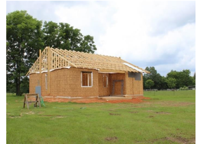
Fig. 192 Buster's Home – Casa en construcción
