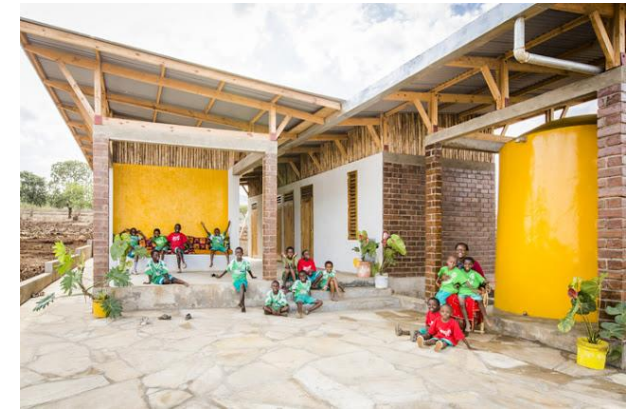
Fig. 156 Casa Baobab – Patio frontal (S.E)
